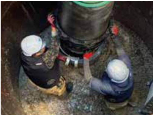
写真5 立坑内での縦配管の状況
