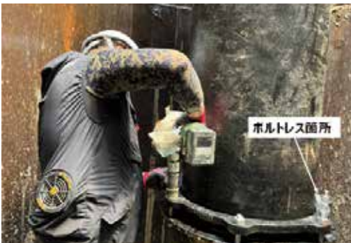
写真6 立坑内でのボルト締め付の状況
