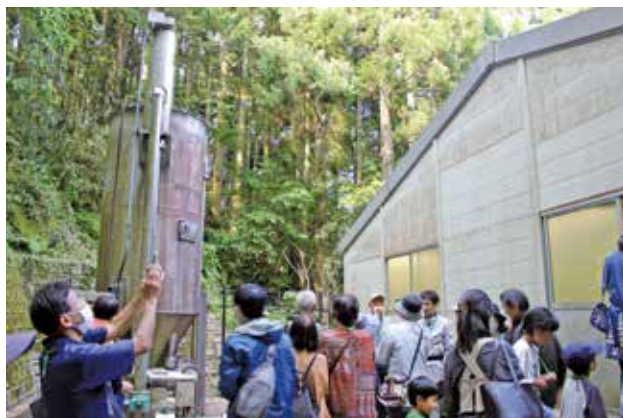
前処理施設と緩速ろ過池建屋 (緩速ろ過浄水場：浄水処理能力 286 \text{m}^3 / 日)
