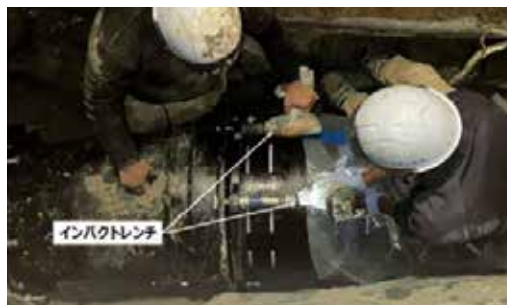
写真3 インパクトレンチでのボルト締付の状況
