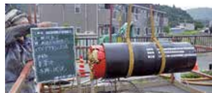
写真5 推進工 (掘進機吊下し)
