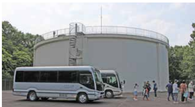
配水池 (有効容量 4,000 \text{m}^3 )
