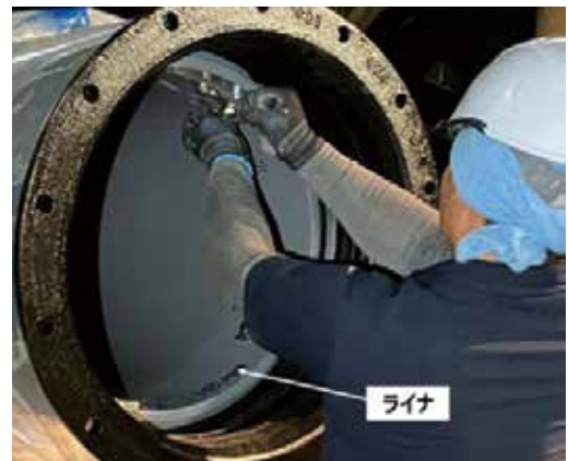
写真8 ライナのセットの状況
