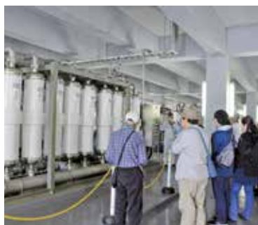
膜ろ過ユニット (基幹浄水場：浄水処理能力 80,000 \text{m}^3 / 日)
