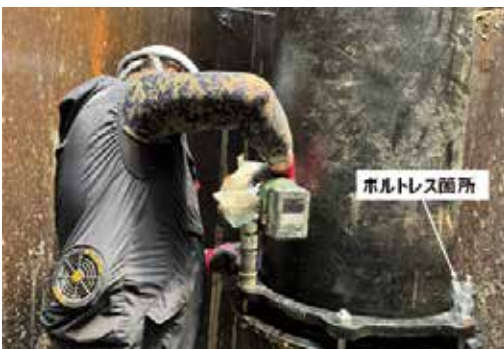
写真 6 立坑内でのボルト締め付の状況
