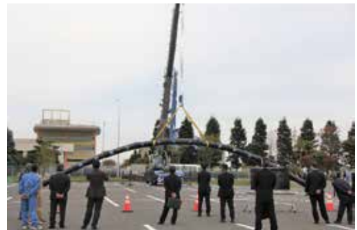
GX形φ500の吊り上げデモンストレーション
