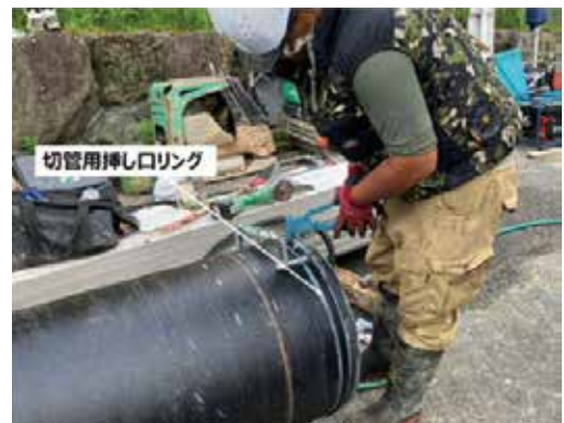
写真 7 切管用挿し口リングのセットの状況
