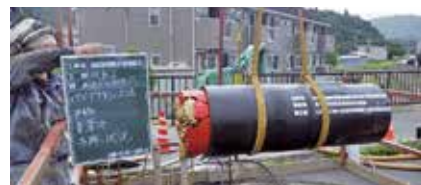
写真5 推進工 (掘進機吊下し)
