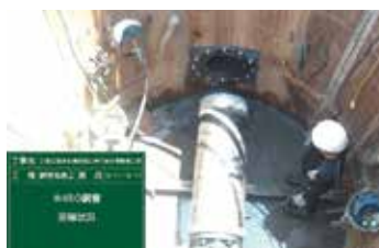
写真6 推進工（鏡切）
