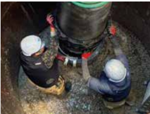
写真 5 立坑内での縦配管の状況
