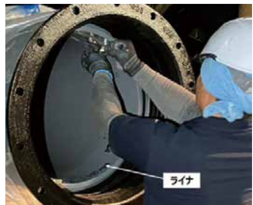
写真 8 ライナのセットの状況
