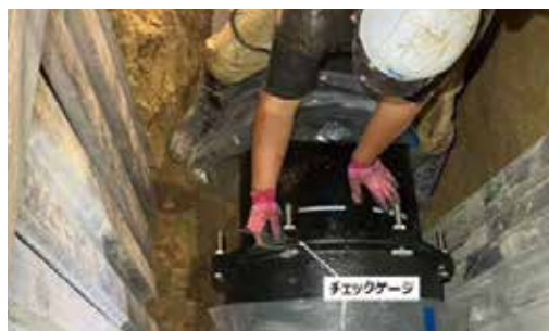
写真4 施工管理の状況(メタルタッチの確認)
