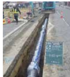
写真2 開削工 (平野部)
