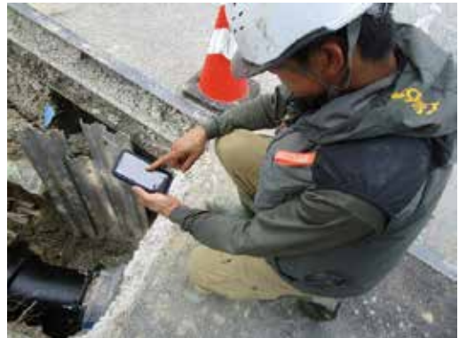
写真9 施工情報入力状況
