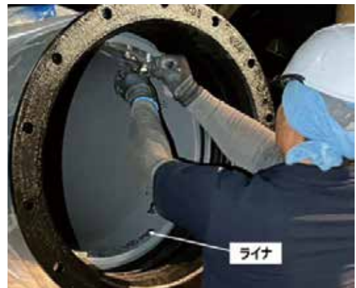
写真8 ライナのセットの状況
