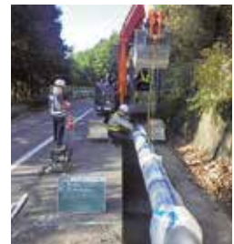
写真3 開削工 (山間部)
