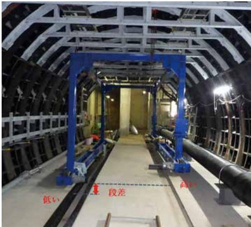
写真 11 門型クレーン設置(インパート段差解消)
