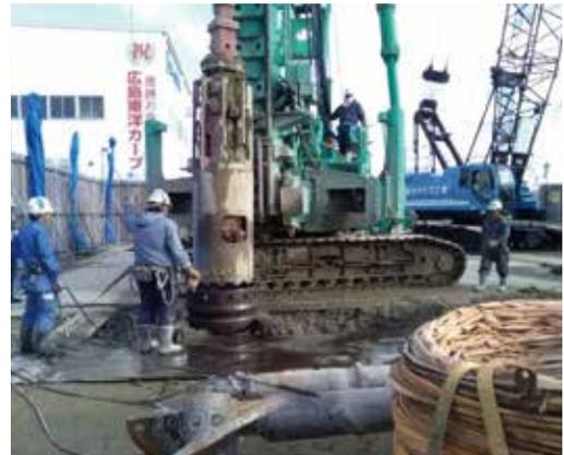
写真5 ロックオーガー施工状況
