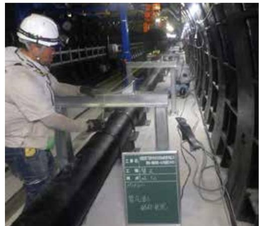
写真17 受架台高さの調整(芯出し測定)
