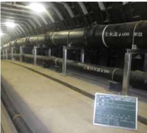
写真 21  $\phi 600$  据付後の線形 通水後の継手状況 (管の動き及び漏れは無し)
