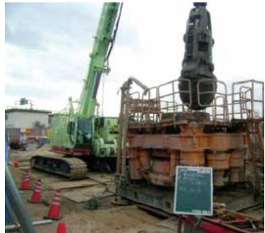
写真6 オールケーシング施工状況
