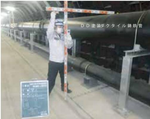
写真3 DD塗装ダクタイル鋳鉄管
