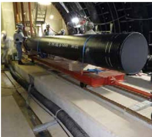
写真 13 シールド内 管運搬
