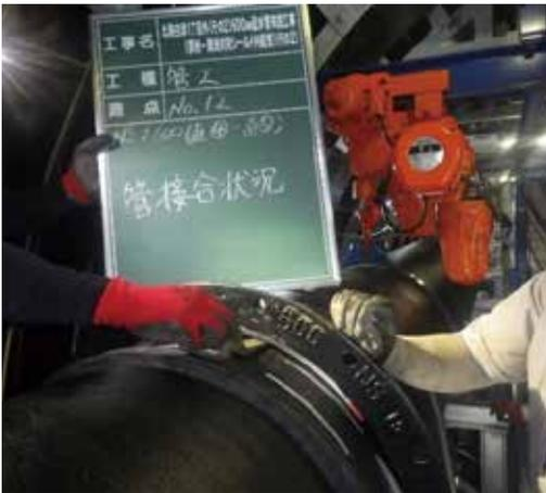
写真 20  $\phi 600$  NS 継手工(偏位測定)
