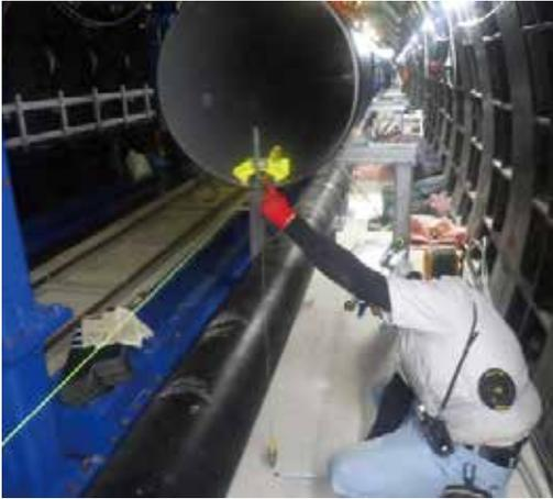
写真 19 継手角度の調整
