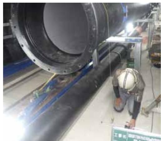
写真18 受架台と継手角度の調整
