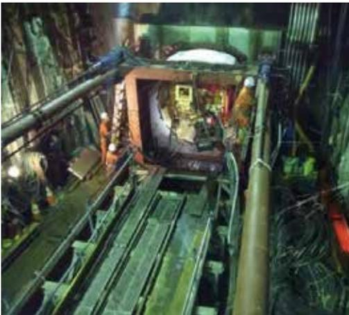
写真9 移動式バックアンカー施工状況
