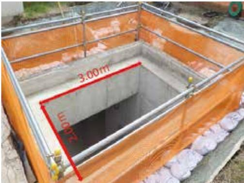
写真5 立坑開口部(材料搬入口)
