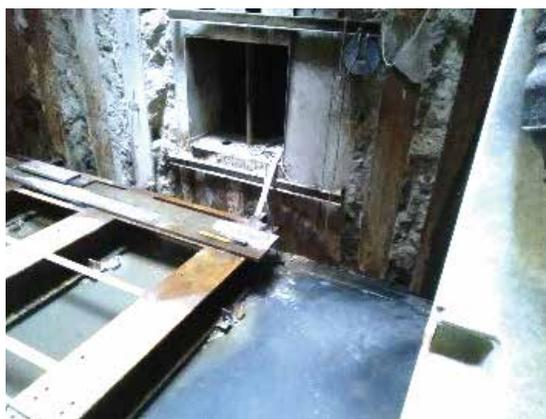
写真8 ガス管布設用貫通部
