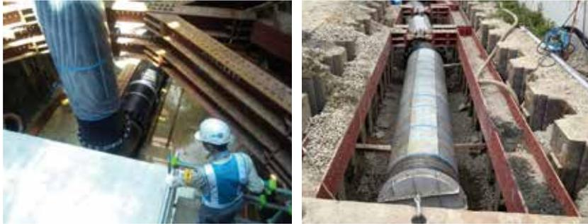
写真3 開削部配管
