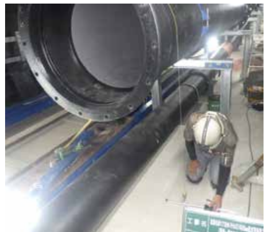
写真18 受架台と継手角度の調整
