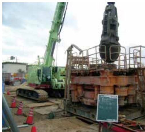
写真6 オールケーシング施工状況
