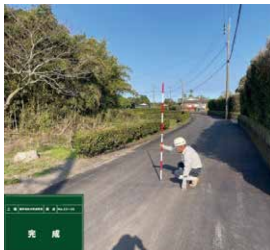
写真6 工事完了(道路復旧後)
