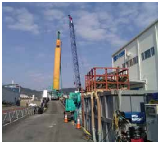
写真4 SMW 施工状況
