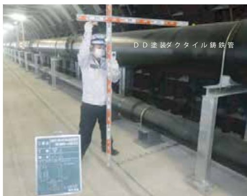
写真3 DD塗装ダクタイル鋳鉄管 新設据付状況
