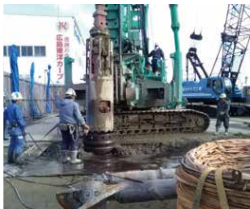
写真5 ロックオーガー施工状況
