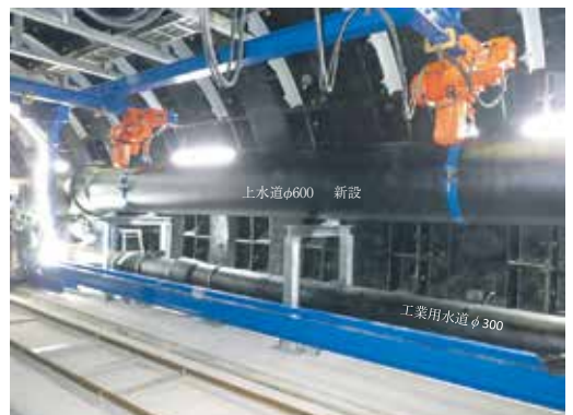
写真 16 シールド内 管据付③
