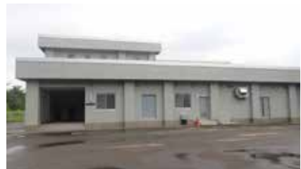
西和賀町柳沢浄水場
