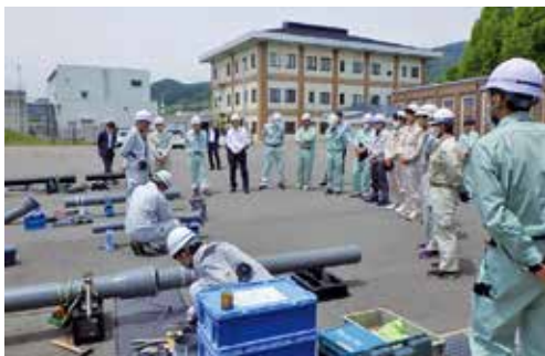
【長野会場】ダクタイル鉄管実技の様子(2024年5月15日)
