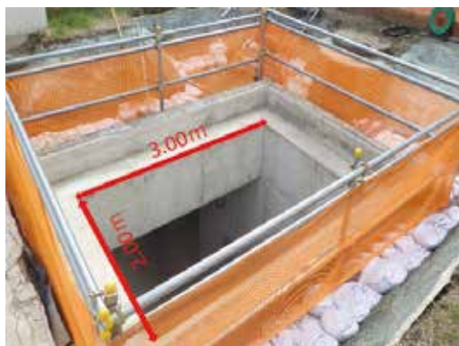
写真5 立坑開口部(材料搬入口)
