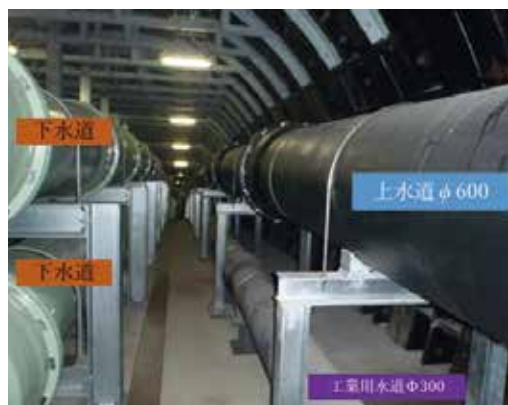
写真4 令和6年度 シールド内巡視・点検 (管据付2年後、塗装状態は健全)
