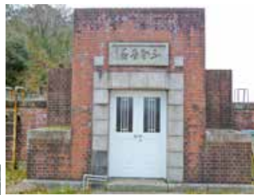
旧佐波浄水場配水池（現在）
