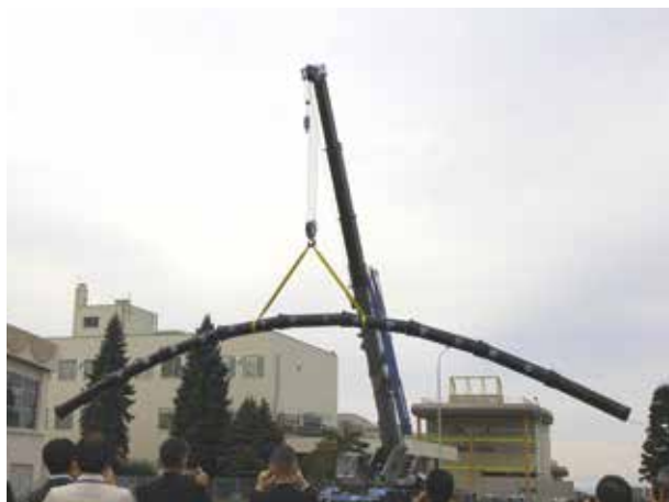
GX 形 \phi 500 の吊り上げのデモンストレーション風景
