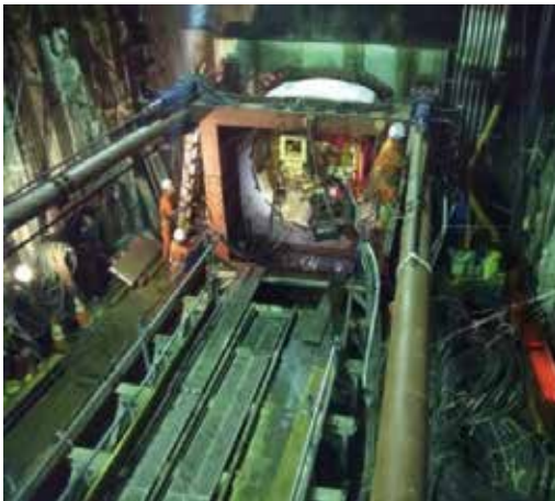
写真9 移動式バックアンカー施工状況
