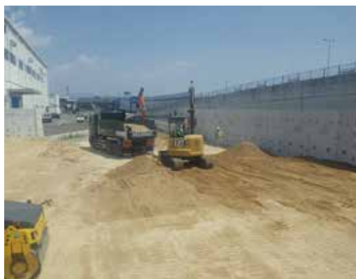
写真 7 発進立坑用地盛土状況
