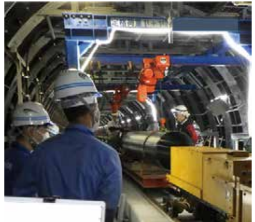
写真 14 シールド内 管据付①
