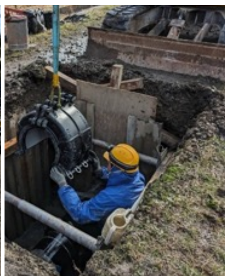
送水管の修繕【2月】
