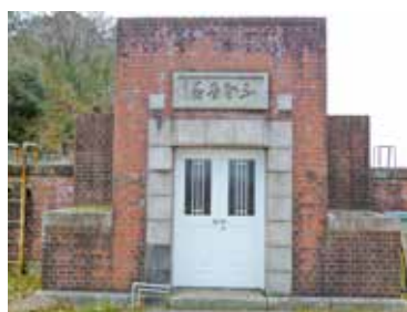
旧佐波浄水場配水池（現在）
