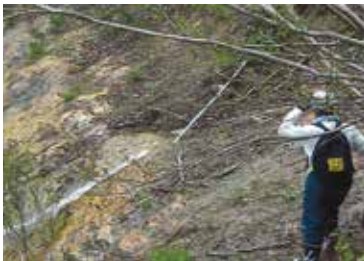
崖にある既存導水管
