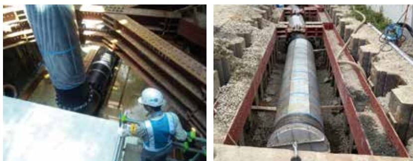
写真3 開削部配管
