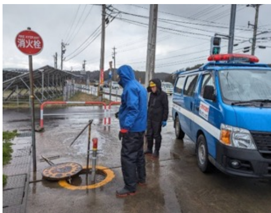
送水管の通水作業【2月】
