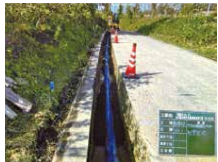
配水管の整備 (DIPGX φ100)
