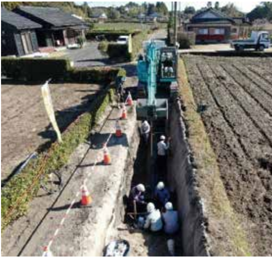
写真3 管布設状況
