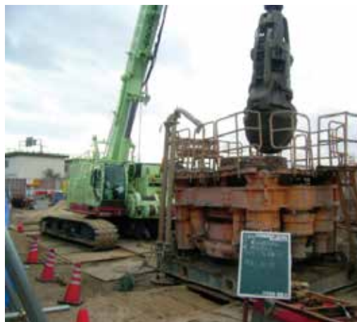
写真6 オールケーシング施工状況
