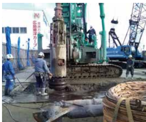
写真5 ロックオーガー施工状況
