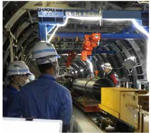
写真 14 シールド内 管据付①
