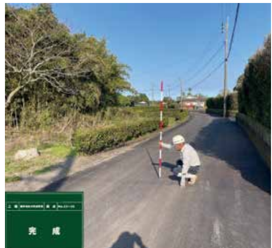
写真6 工事完了(道路復旧後)
