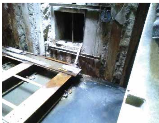
写真 8 ガス管布設用貫通部
