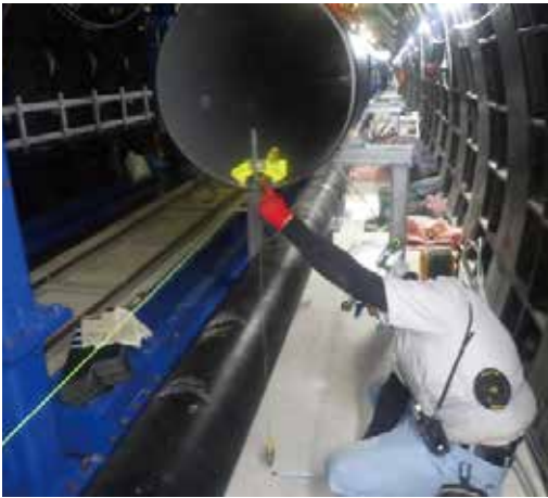
写真 19 継手角度の調整
