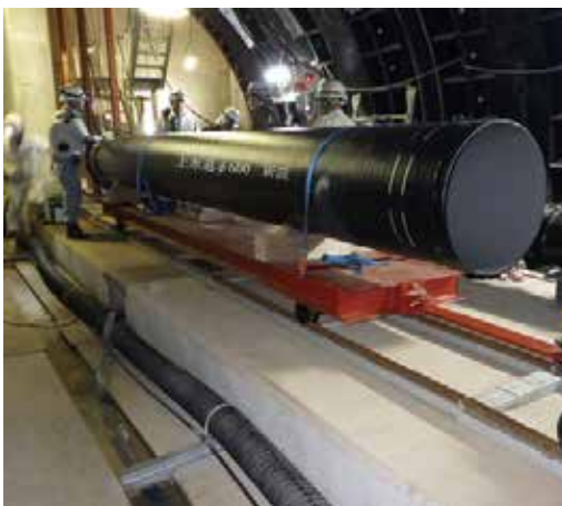
写真 13 シールド内 管運搬
