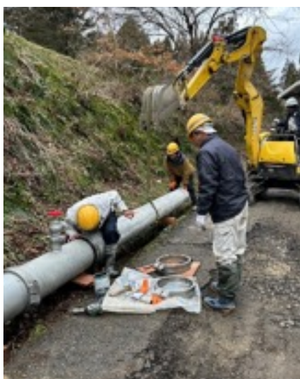
送水管の仮設配管【2月】
