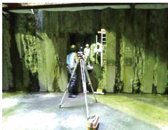
写真 8 ガス管布設用貫通部
