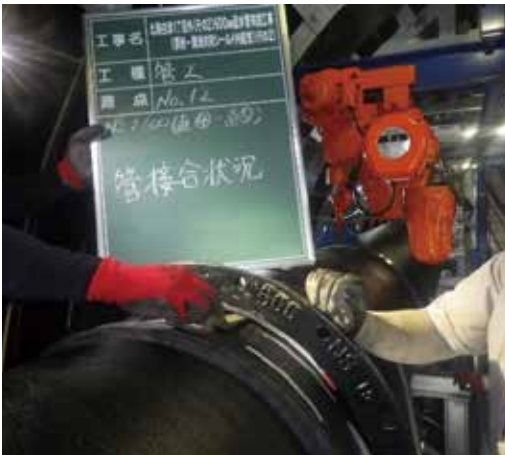
写真 20 φ600 NS 継手工(偏位測定)
