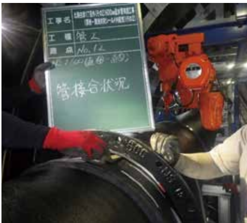
写真 20 φ600 NS 継手工(偏位測定)
