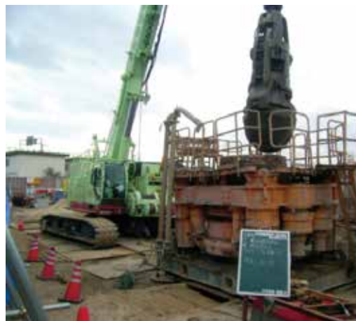
写真6 オールケーシング施工状況
