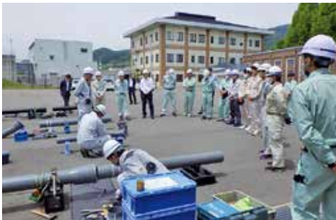
【長野会場】ダクタイル鉄管実技の様子(2024年5月15日)
