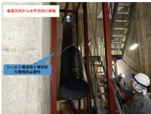
写真8 φ600 構内吊り下し
