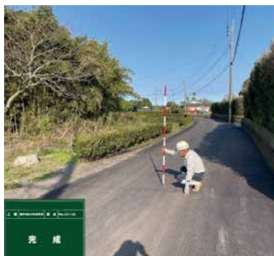
写真 6 工事完了(道路復旧後)
