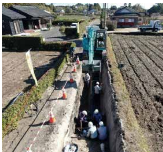
写真 3 管布設状況
