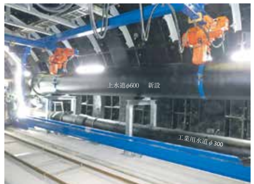
写真 16 シールド内 管据付③
