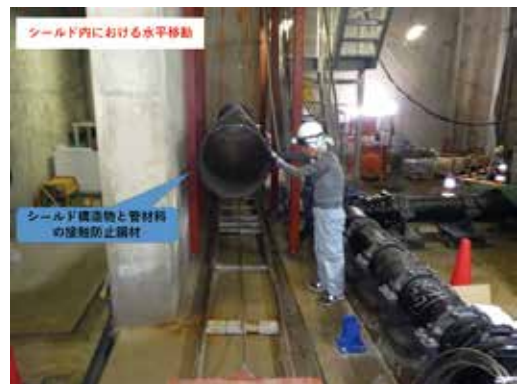
写真9 φ600 構内運搬
