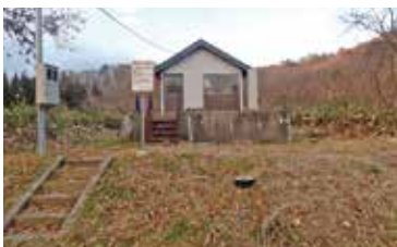
山内黒沢地区の黒沢第二配水池
