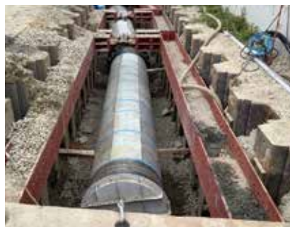
写真3 開削部配管
