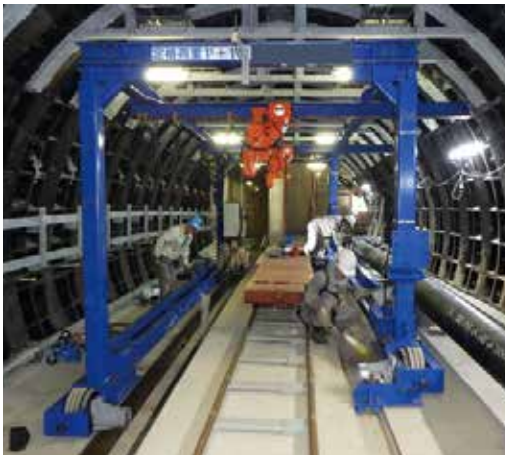
写真 12 シールド内 門型クレーン組立
