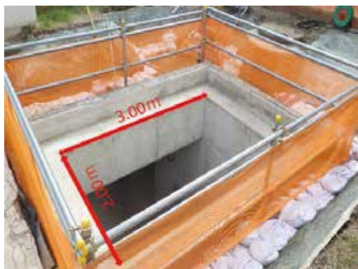
写真5 立坑開口部(材料搬入口)
