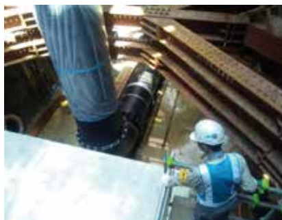
写真3 開削部配管
