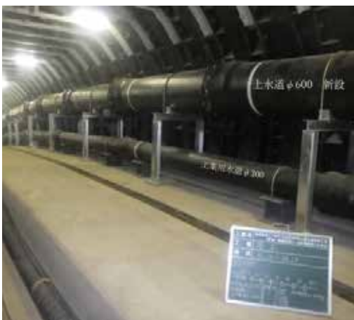
写真 21 φ600 据付後の線形 通水後の継手状況 (管の動き及び漏れは無し)
