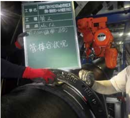
写真 20 φ600 NS 継手工(偏位測定)
