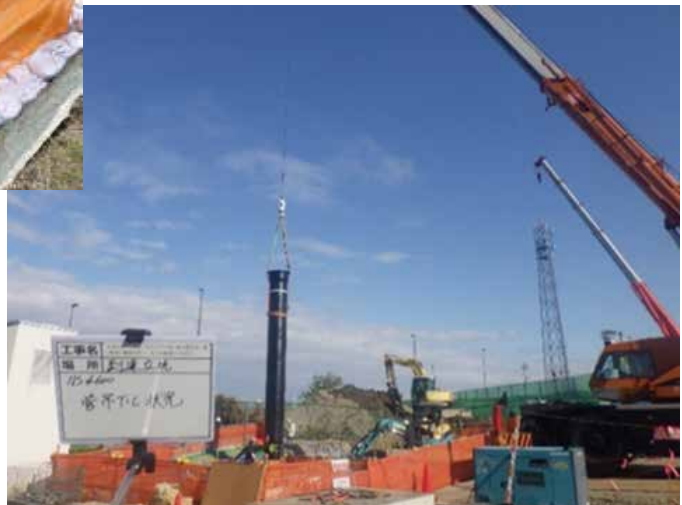
写真6 φ600 材料吊り下し
