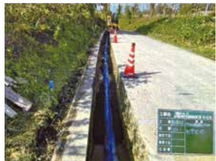
配水管の整備 (DIPGX φ100)
