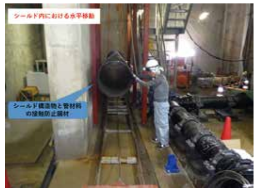
写真9 φ600 構内運搬
