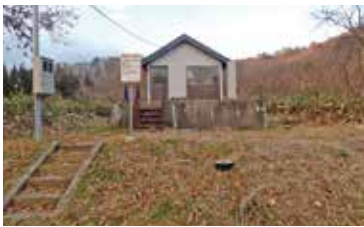
山内黒沢地区の黒沢第二配水池
