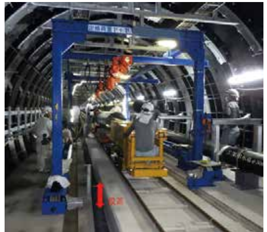
写真 15 シールド内 管据付②
