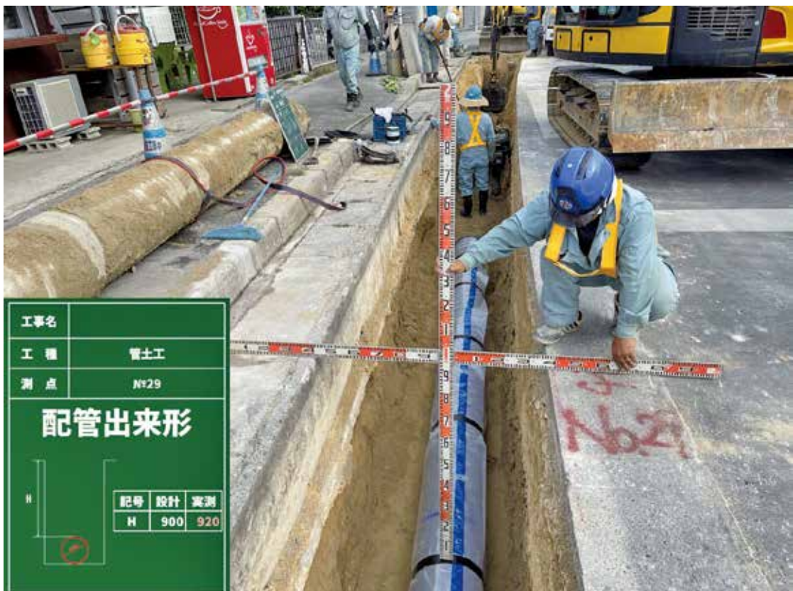
うるま市水道部（沖縄県） GX 形 呼び径 300
