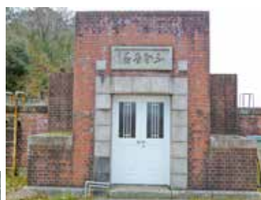
旧佐波浄水場配水池（現在）
