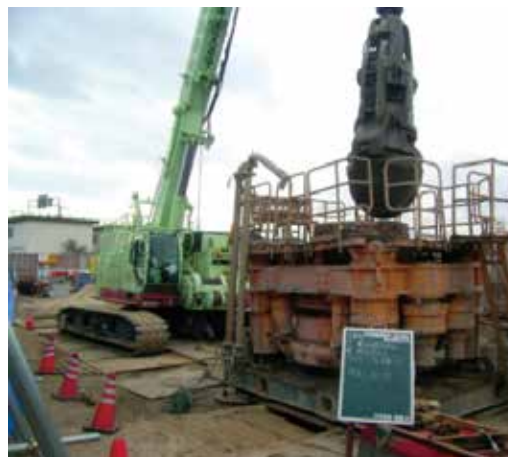
写真6 オールケーシング施工状況
