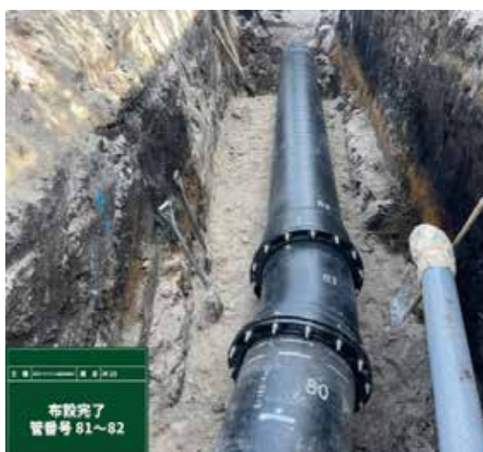
写真5 布設完了
