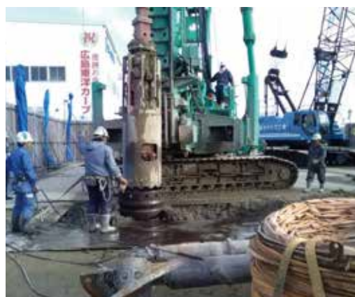
写真5 ロックオーガー施工状況
