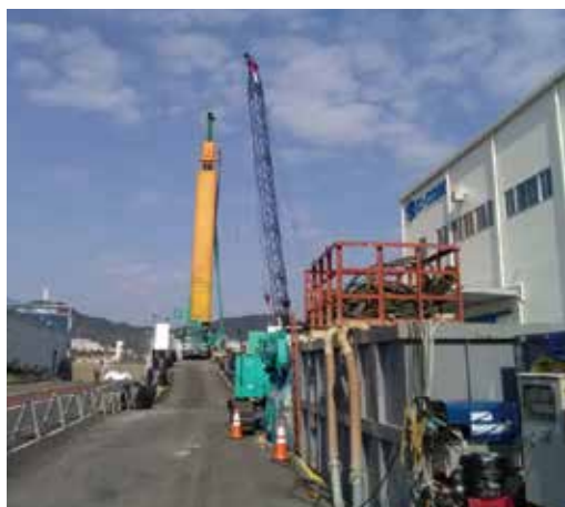
写真4 SMW 施工状況
