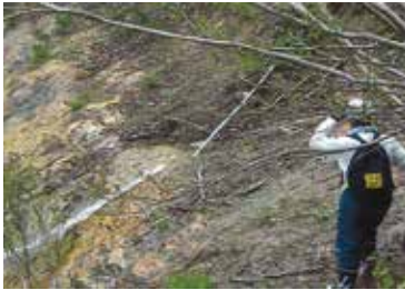
崖にある既存導水管
