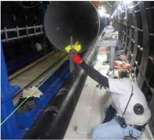
写真 19 継手角度の調整
