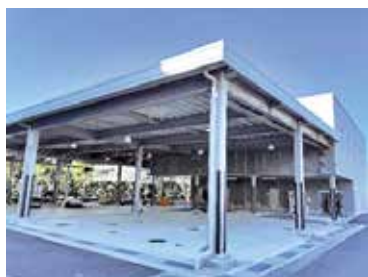
水道技術研修施設
