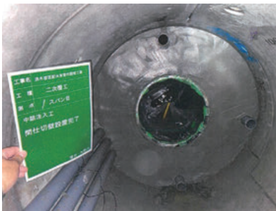
写真7 間仕切壁設置完了状況
