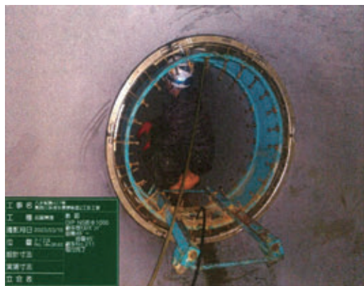
写真3 テストバンド設置(NS形曲管90°)
