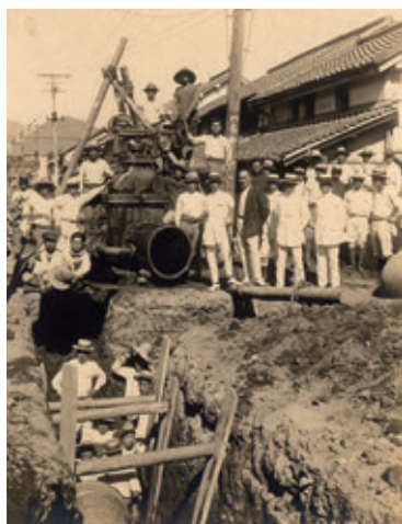
水道創設時 立町通仕切弁設置工事
