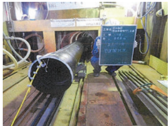
写真6 シールド内への PN 形管搬入状況
