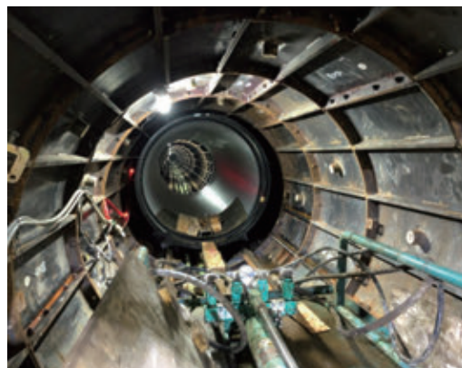
写真2 シールド内 PN 形管運搬状況
