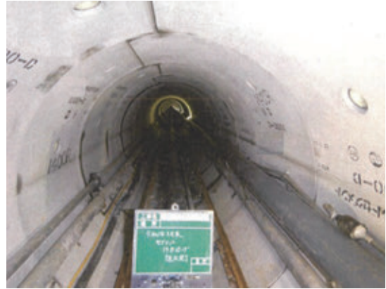
写真4 1次覆工セグメント組立完了
