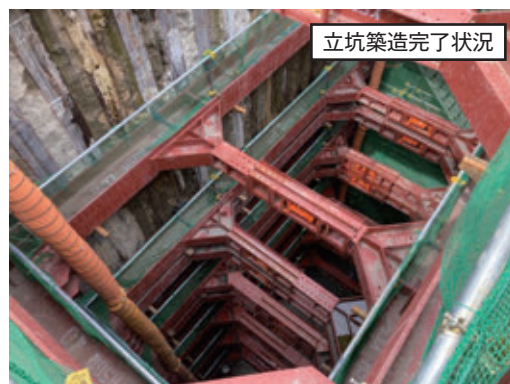
写真③ 発進立坑 (その 2 工区)
