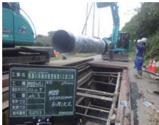
写真1 布設替工(管吊り降ろし)
