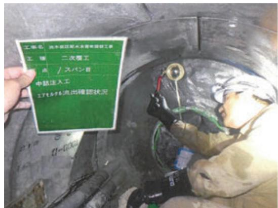
写真8 気泡モルタル充填完了
