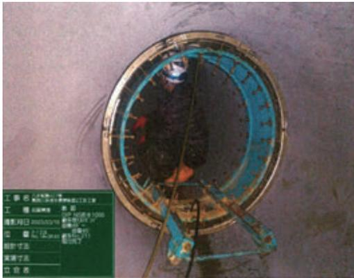
写真3 テストバンド設置(NS形曲管90°)
