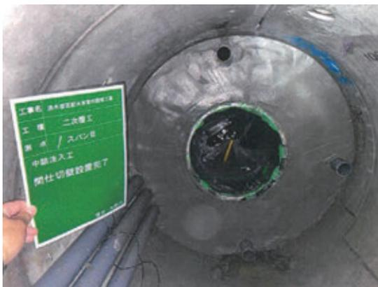
写真7 間仕切壁設置完了状況
