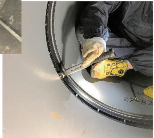
写真6 PN形ダクタイル鉄管接合状況
