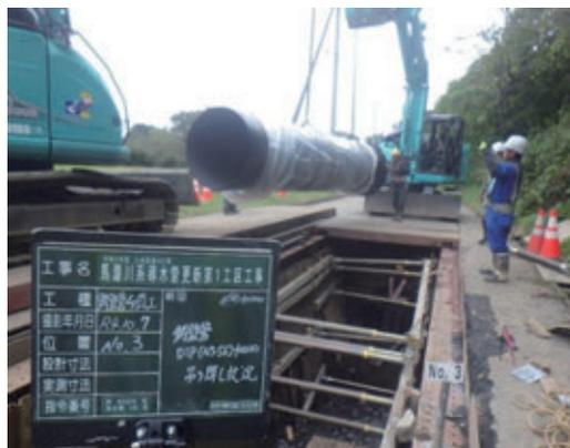
写真1 布設替工(管吊り降ろし)
