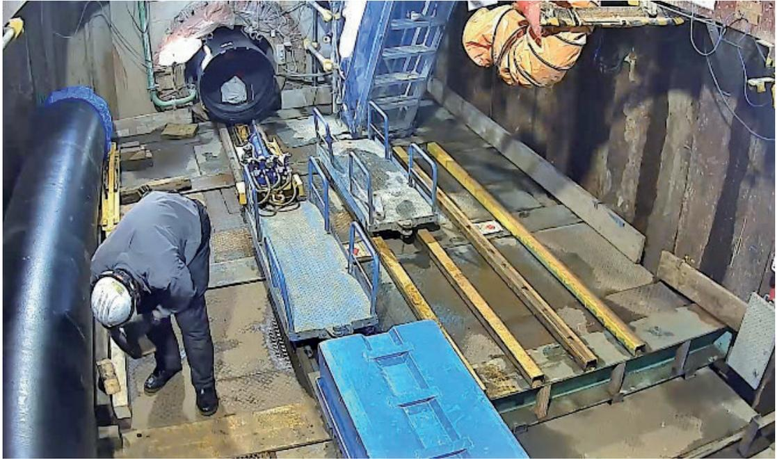
写真4 PN形ダクタイル鉄管運搬状況(立坑内)
