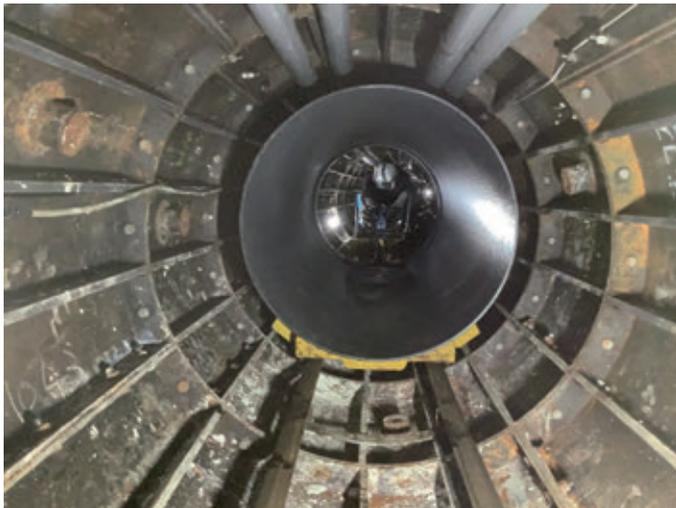
写真5 PN形ダクタイル鉄管運搬状況(さや管内)
