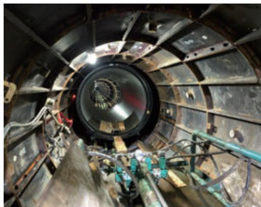
写真2 シールド内 PN 形管運搬状況
