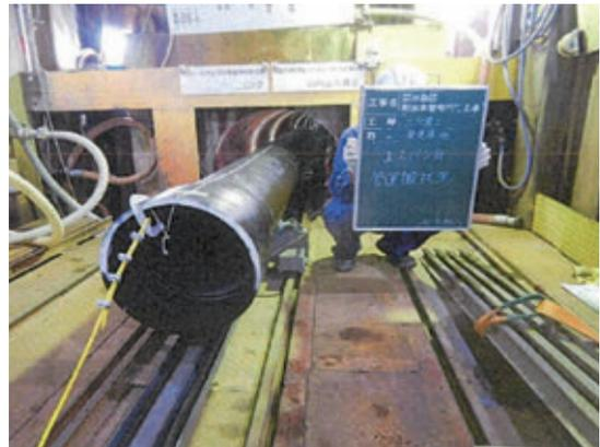
写真6 シールド内へのPN形管搬入状況
