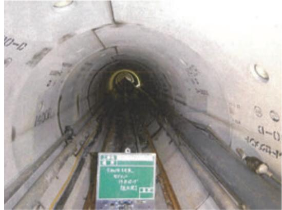
写真4 1次覆工セグメント組立完了
