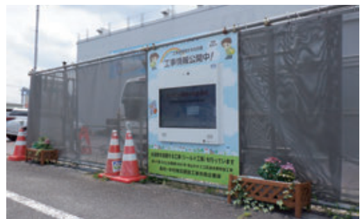
写真⑥ デジタルサイネージの設置状況 (白線は、歩行者と自転車に分けるものです。)
