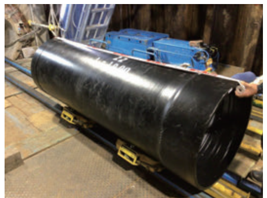
写真 3 PN 形ダクタイル鉄管
