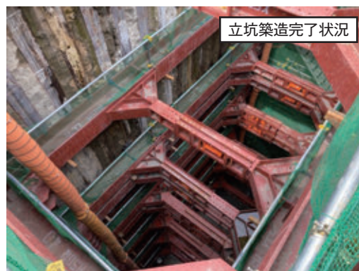
写真③ 発進立坑 (その 2 工区)
