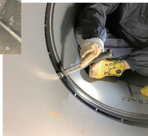
写真6 PN形ダクトイル鉄管接合状況
