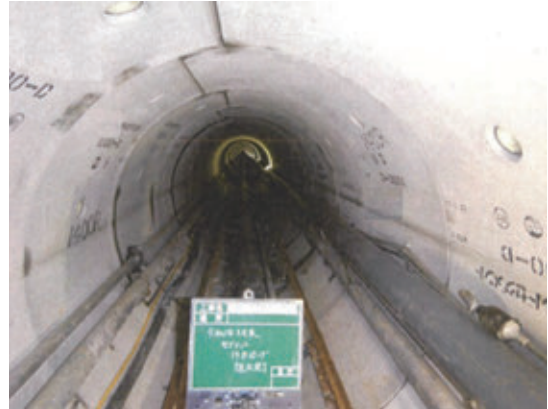
写真4 1次覆工セグメント組立完了
