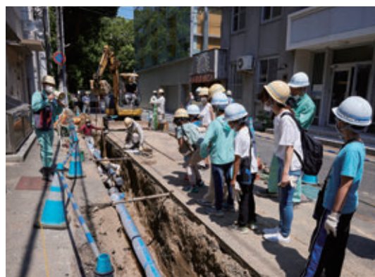
現場見学（配水管工事）
