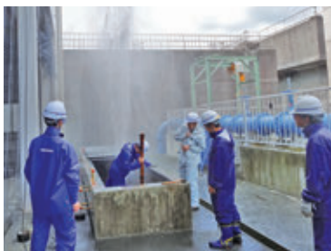
木栓による不断水工法
