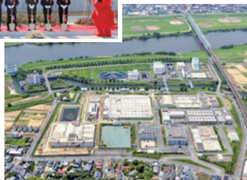
ちば野菊の里浄水場 令和6年6月
