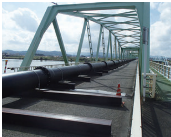
仮復旧管路の状況
