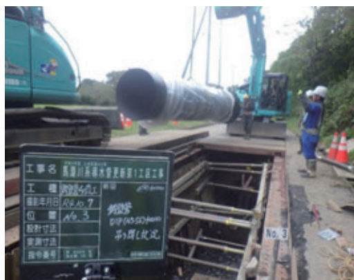
写真1 布設替工(管吊り降ろし)
