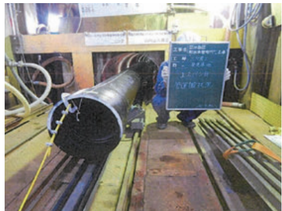
写真6 シールド内への PN 形管搬入状況
