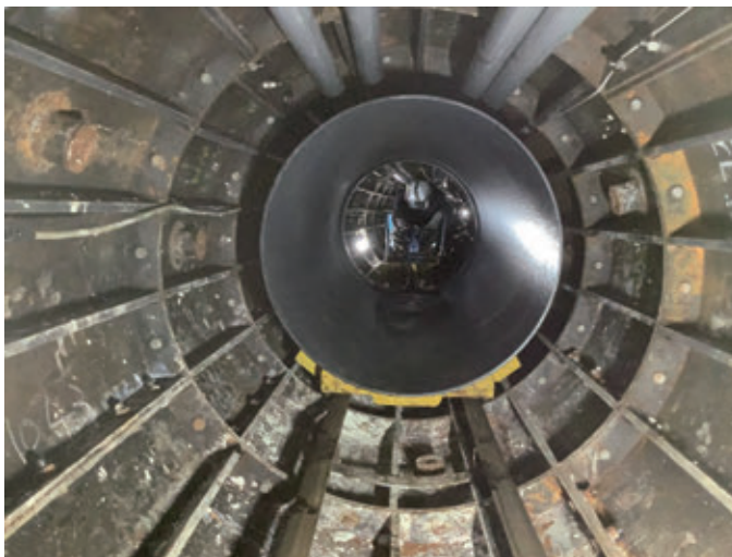
写真5 PN形ダクトイル鉄管運搬状況(さや管内)
