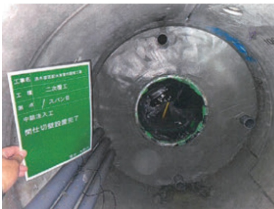
写真7 間仕切壁設置完了状況
