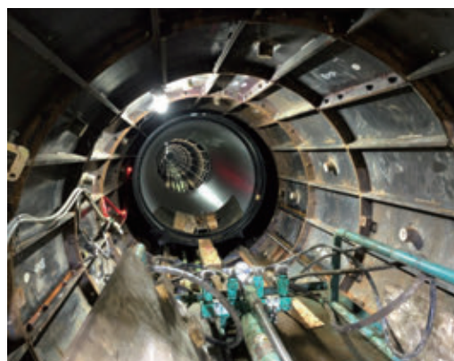
写真2 シールド内 PN 形管運搬状況
