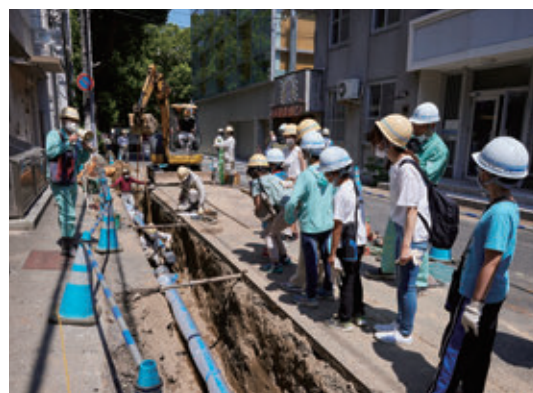
現場見学（配水管工事）
