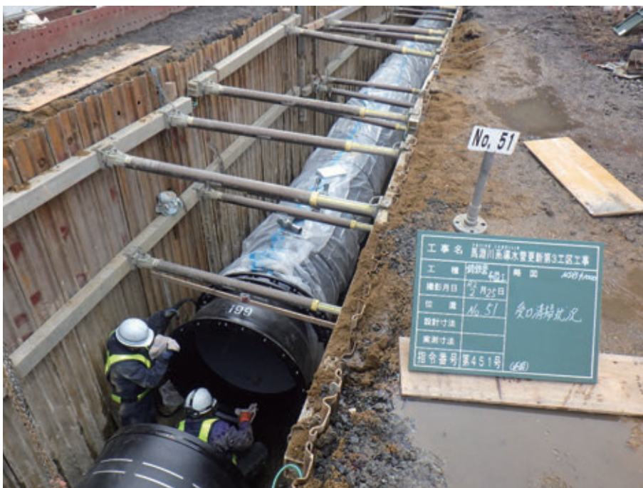
八戸圏域水道企業団(青森県) PN形 呼び径1000 / NS形 呼び径1000
