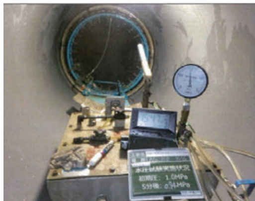
写真4 テストバンド水压試験状況(PN形)
