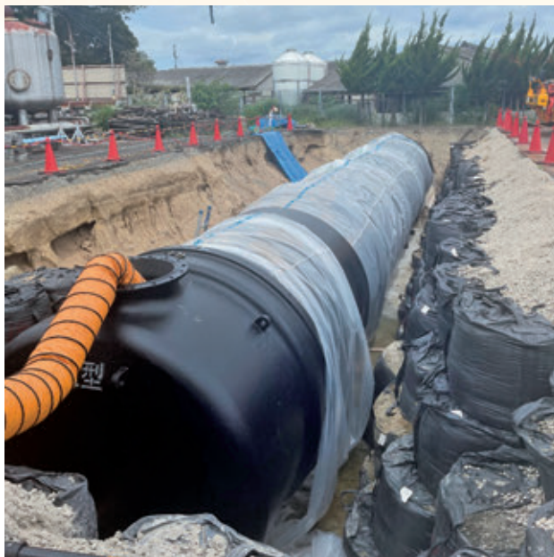
大阪広域水道企業団 田尻水道センター LUF 形 呼び径 2600
