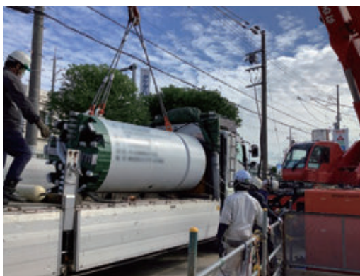
写真 2 シールドマシン搬入状況
