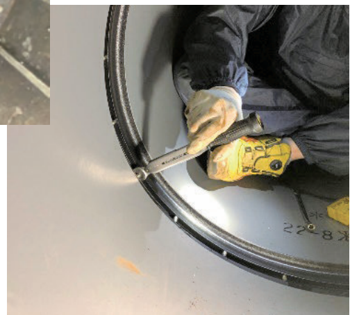
写真6 PN形ダクトイル鉄管接合状況
