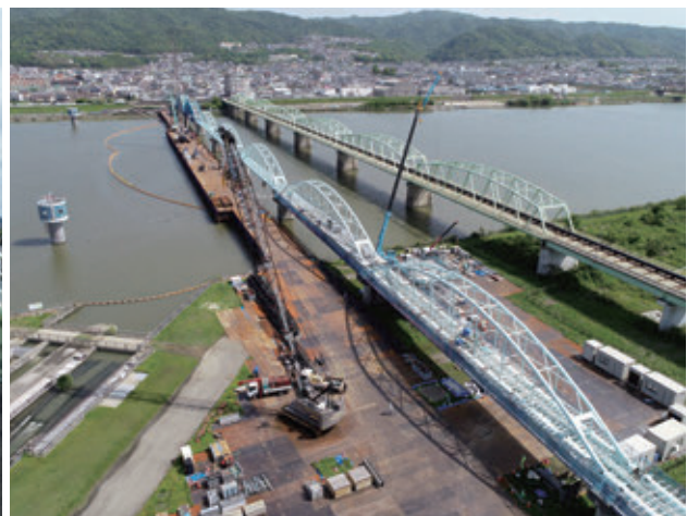
本復旧工事の状況
