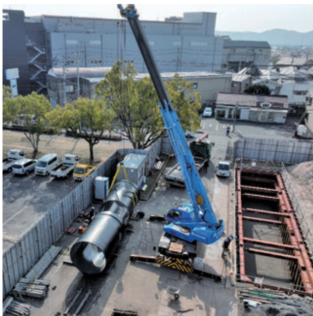
倉敷市水道局（岡山県） LUF 形 呼び径 2600
