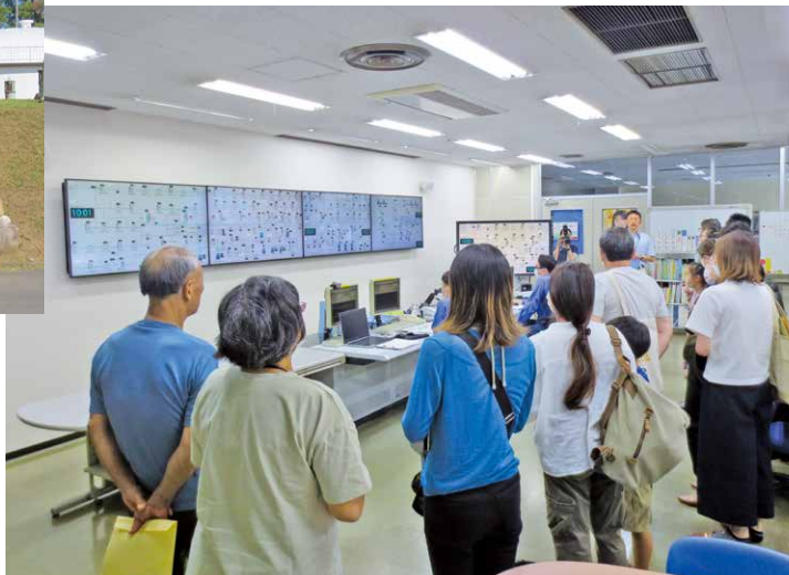
施設見学 中央監視室
