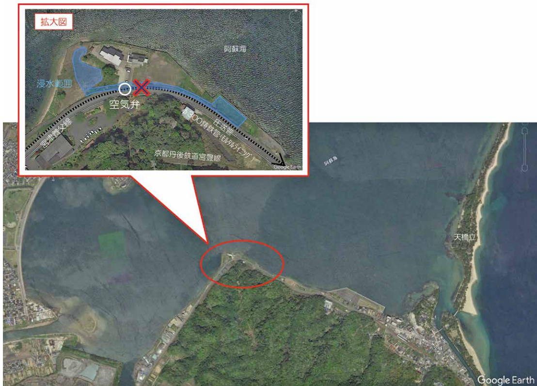
図3 漏水発生箇所
