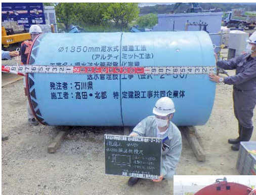
写真3 泥水式推進機械
