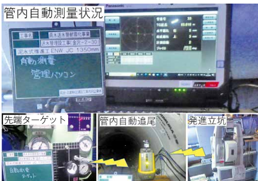
写真4 掘進機自動測量状況
