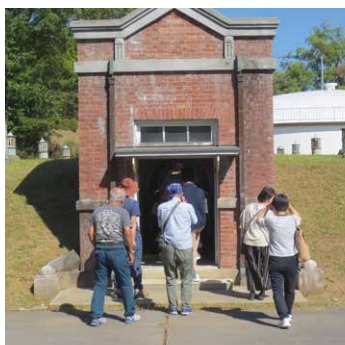
施設見学 城山配水地
