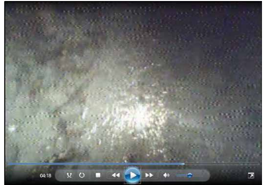
写真1 カメラ調査での管内状況写真(1)
