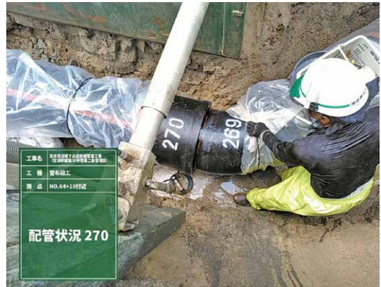
写真4 NS形ダクトイル鉄管の接合状況(2)
