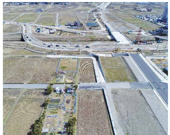
写真2 施工範囲周辺の状況
