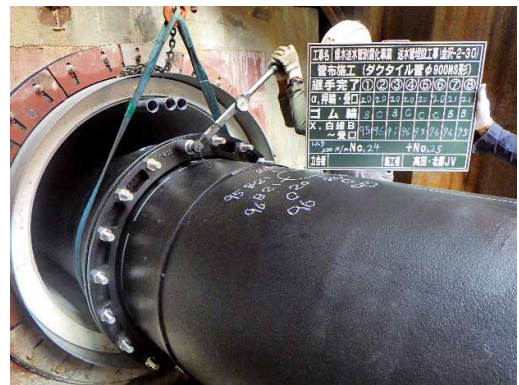
写真7 NS形継手接合状況
