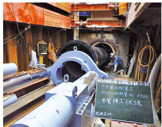
写真8 管挿入状況
