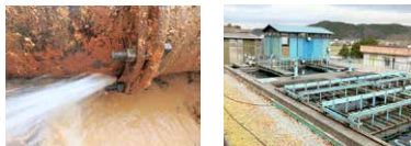
老朽化した水道管と浄水施設の写真
