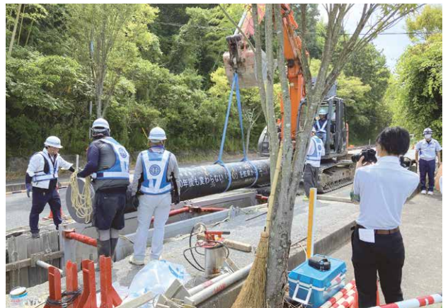
「タイム送水管」埋設の様子
