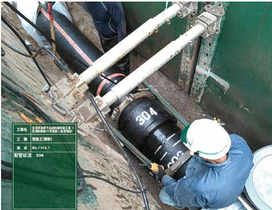
写真3 NS形ダクトイル鉄管の接合状況(1)
