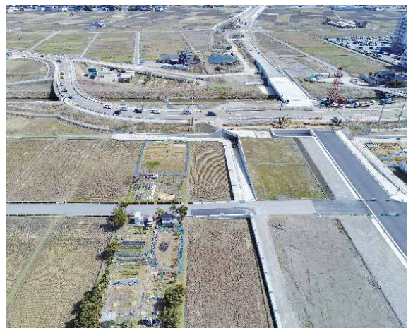
写真2 施工範囲周辺の状況
