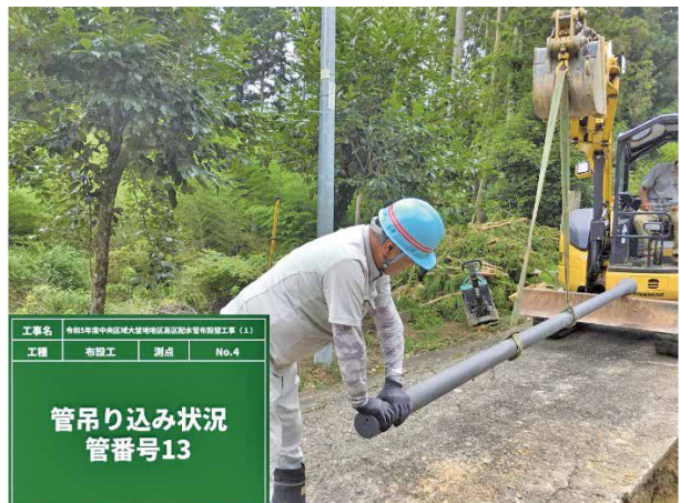
写真3 管吊り込み状況
