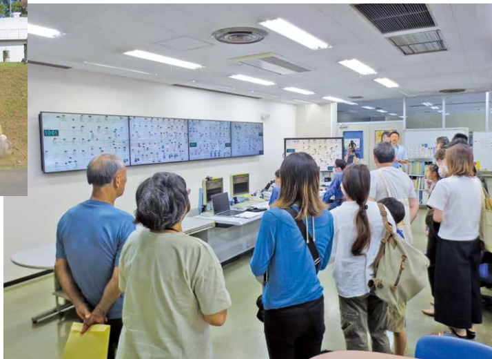
施設見学 中央監視室
