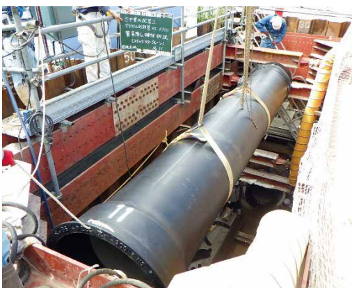
写真6 管吊り込み据え付け状況
