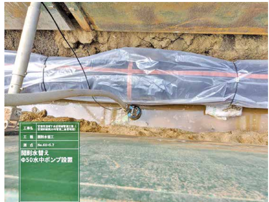
写真6 流入した山地水の水替え
