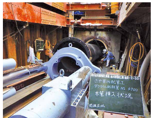
写真8 管挿入状況
