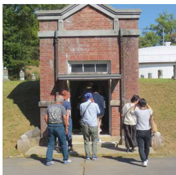
施設見学 城山配水地
