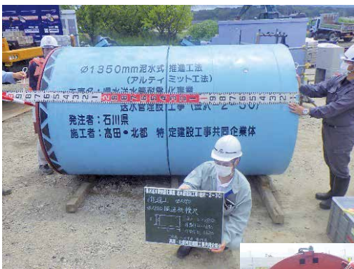
写真3 泥水式推進機械
