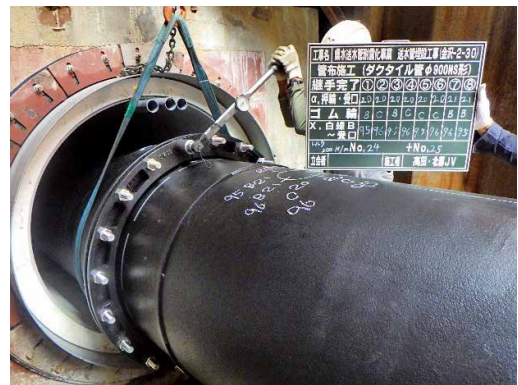
写真7 NS形継手接合状況
