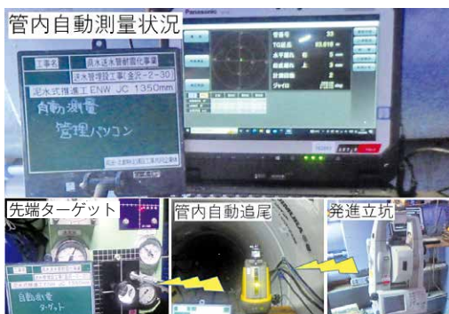
写真4 掘進機自動測量状況
