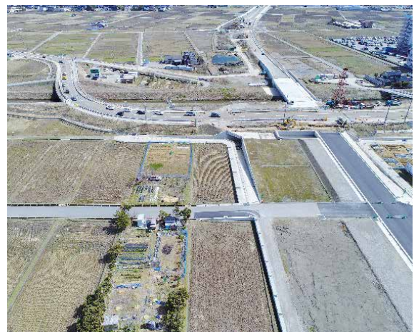
写真2 施工範囲周辺の状況
