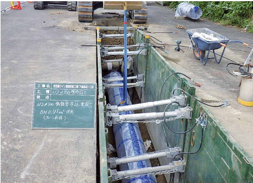
広島県水道広域連合企業団 広島水道事務所 NS形 呼び径 500
