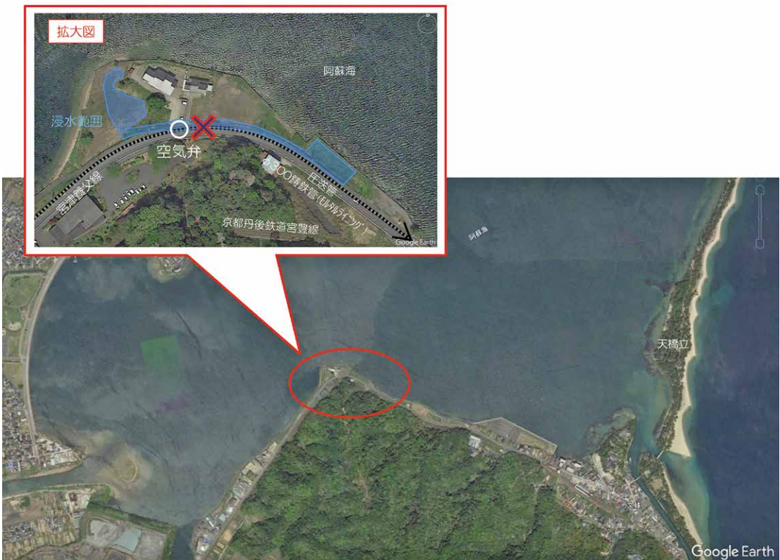
図3 漏水発生箇所
