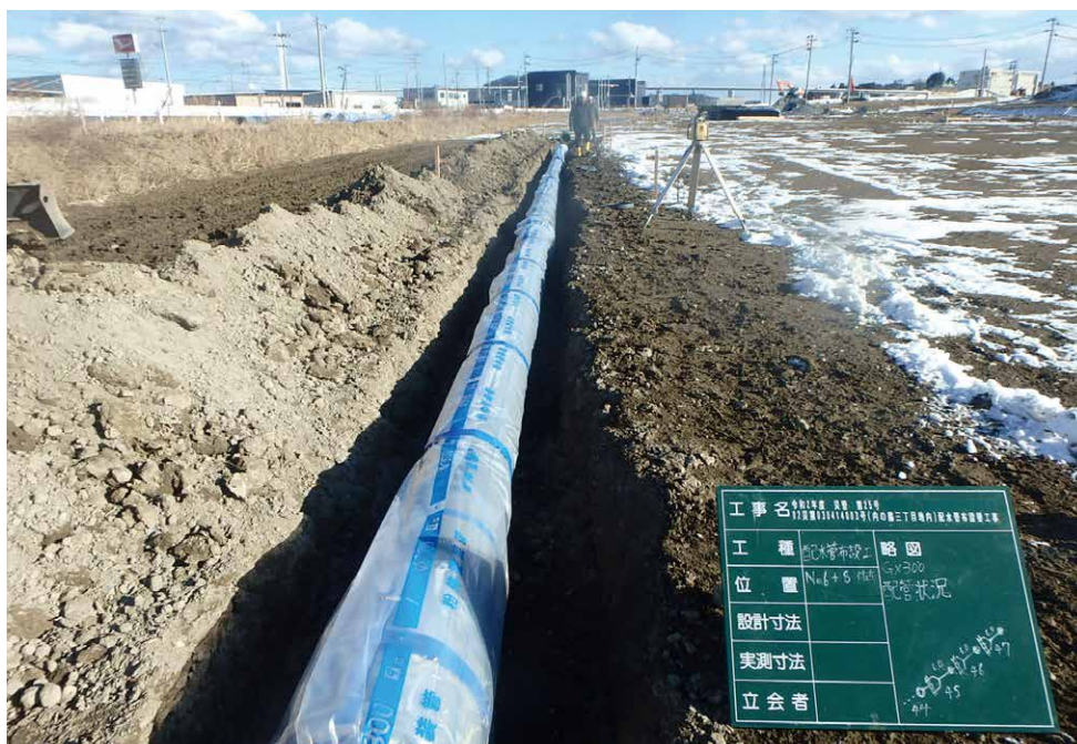
内の脇地内復旧復興工事（気仙沼市）
