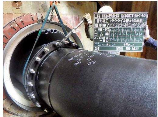
写真7 NS形継手接合状況
