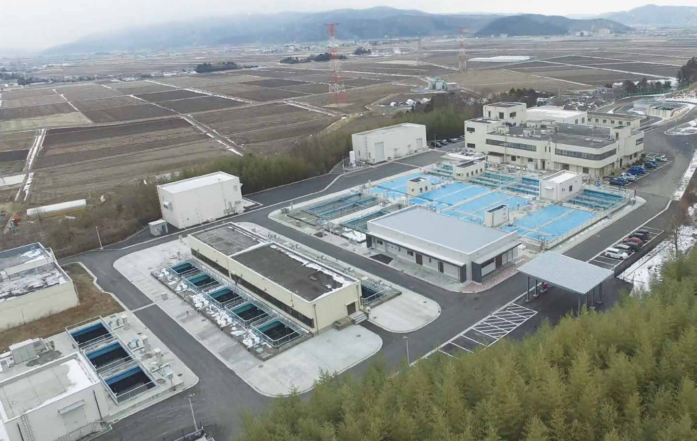
須江山浄水場（石巻地方広域水道企業団）
