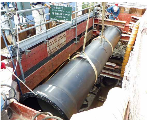
写真6 管吊り込み据え付け状況
