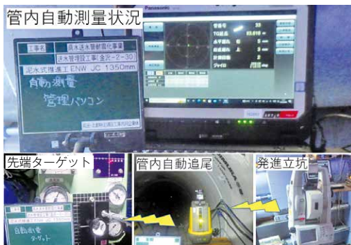
写真4 掘進機自動測量状況
