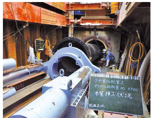
写真8 管挿入状況
