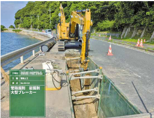
写真5 海岸地域での施工状況(掘削)
