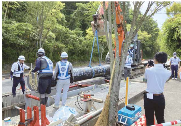
「タイム送水管」埋設の様子
