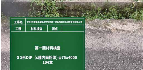
写真2 材料検査状況
