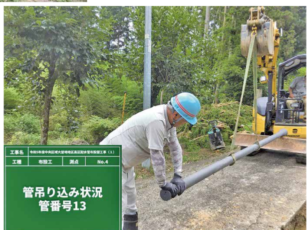
写真3 管吊り込み状況
