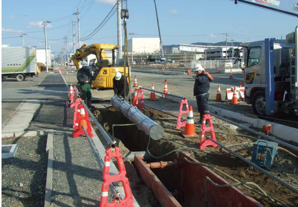
配水管（魚町）布設（石巻地方広域水道企業団）
