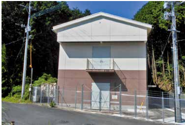
栗面中継ポンプ場
