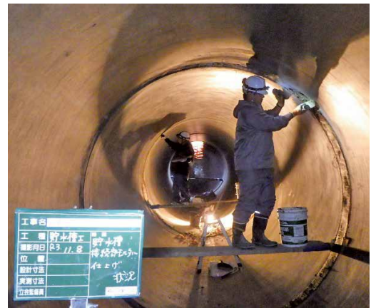
写真7 直管接合部モルタル仕上げ状況
