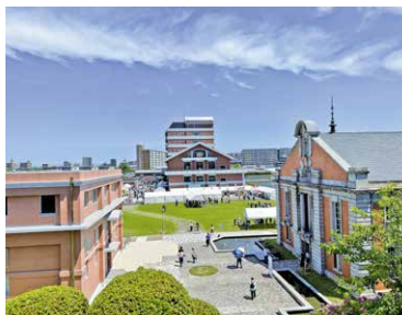
水フェスタ会場 (旧第一ポンプ所)
