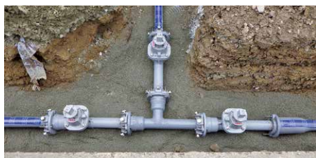
写真3 S50形配管状況②
