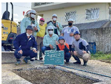
漏水修理を終えて記念撮影
