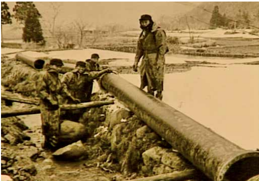
写真2 配水管の敷設状況
