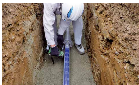
写真4 S50形配管状況③
