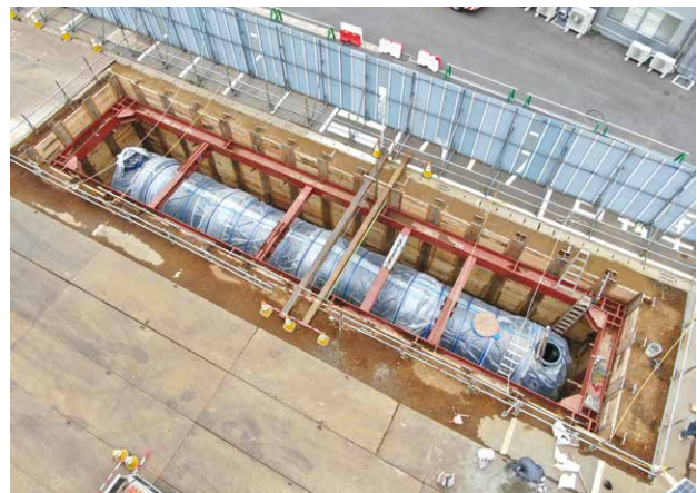
緊急用貯水槽据付け状況
