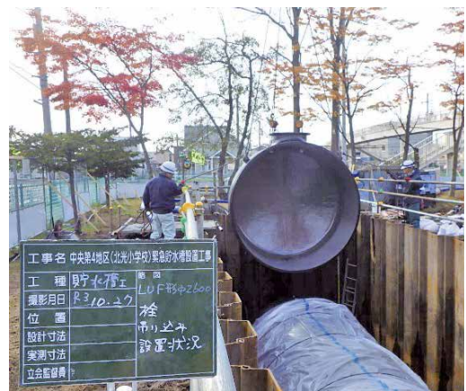
写真4 栓吊り込み設置状況
