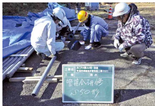
写真1 業者接合研修受講状況
