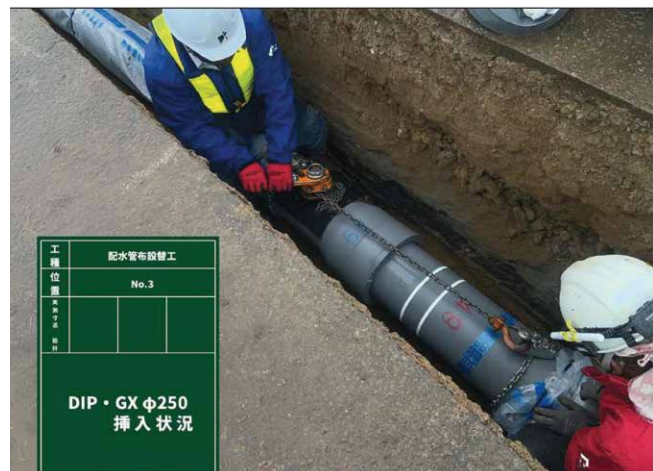
施工現場（会津若松市）
