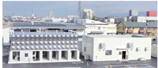
写真6 南石関ポンプ場の完成
