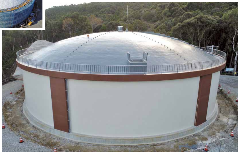
津久葉第3配水池
