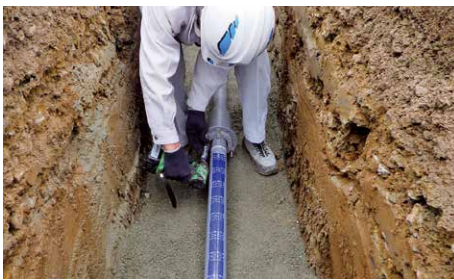
写真4 S50形配管状況③
