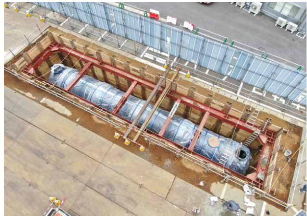
緊急用貯水槽据付け状況
