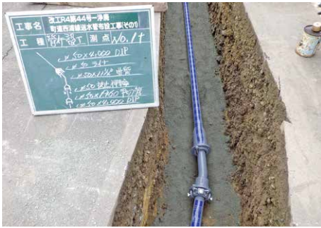
写真2 S50形配管状況①
