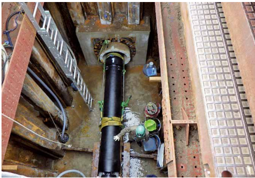
写真4 PN管挿入状況
