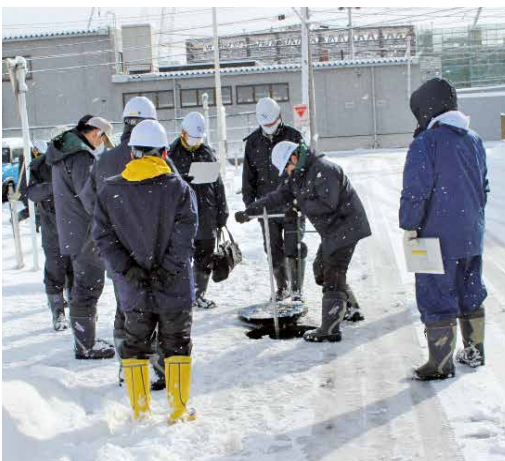
写真9 南石関ポンプ場総合試運転 (施設全体の性能を確認するため、 災害時の運用を想定し行った。)
