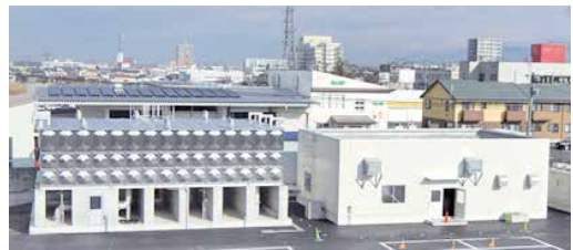
写真6 南石関ポンプ場の完成
