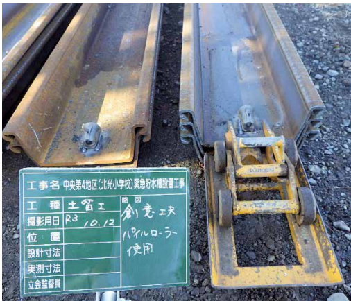
写真2 パイルローラーによる騒音対策
