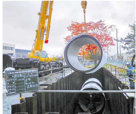
写真3 直管吊り込み設置状況
