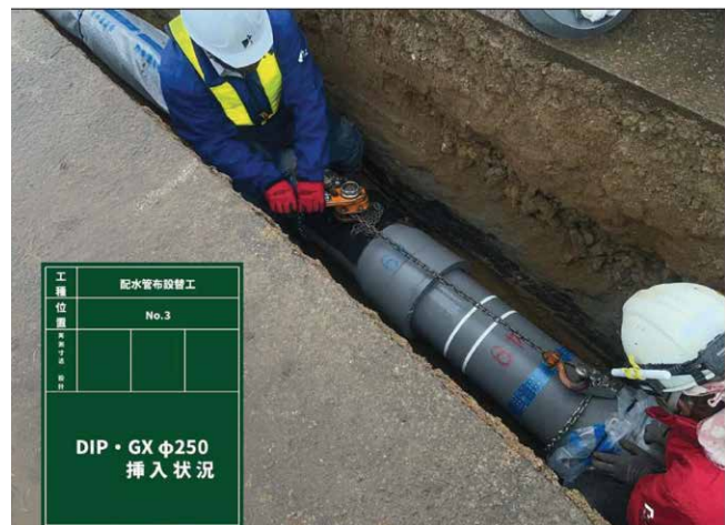
施工現場（会津若松市）
