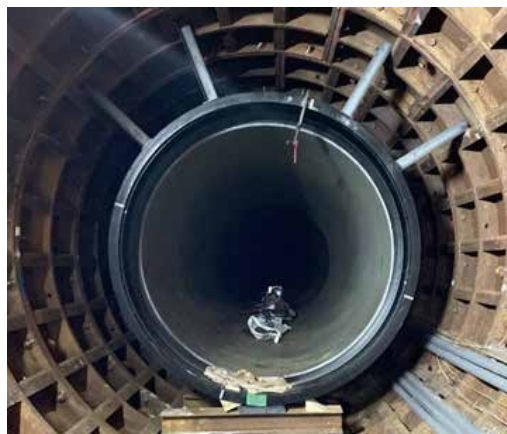
写真 3 US形ダクタイル鉄管R方式配管状況
