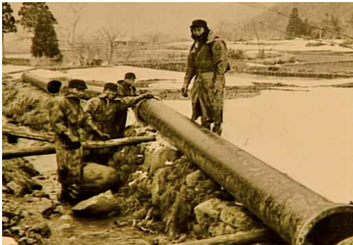
写真2 配水管の敷設状況
