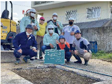
漏水修理を終えて記念撮影
