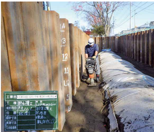
写真6 貯水槽埋戻し状況
