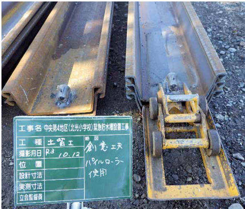
写真2 パイルローラーによる騒音対策
