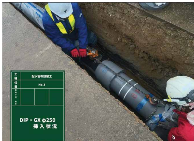
施工現場（会津若松市）
