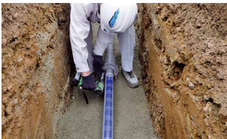
写真4 S50形配管状況③
