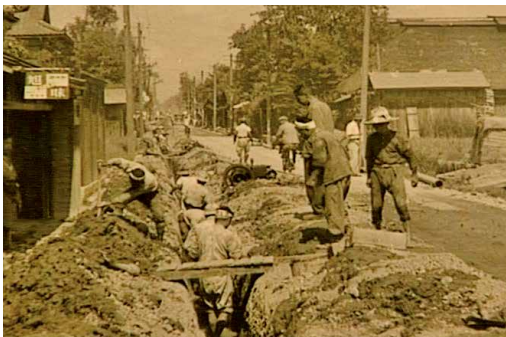
写真3 人力による掘削状況
