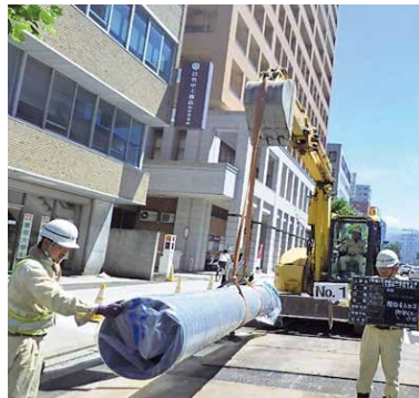
写真7 松原1号の配水管布設工事 (NS形呼び径500)
