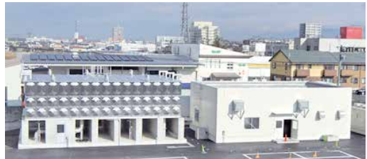
写真6 南石関ポンプ場の完成
