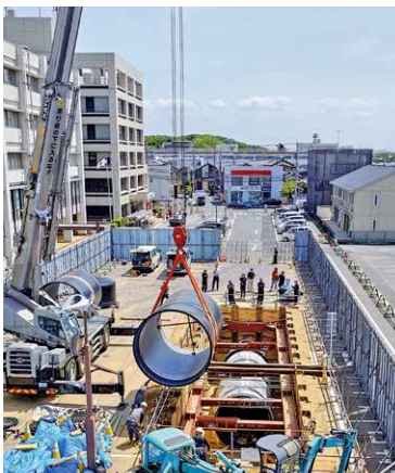
緊急用貯水槽吊込み状況
