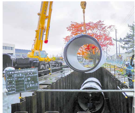
写真3 直管吊り込み設置状況
