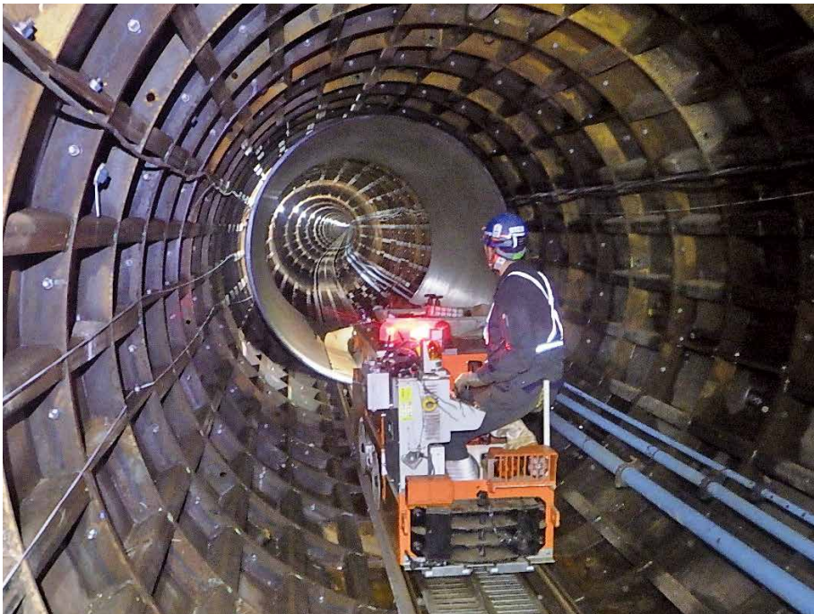
北千葉広域水道企業団(千葉県) US形R方式 呼び径 2400
