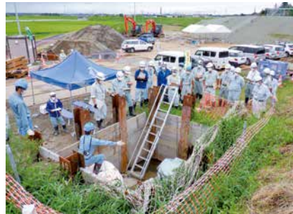
不断水施工現場研修
