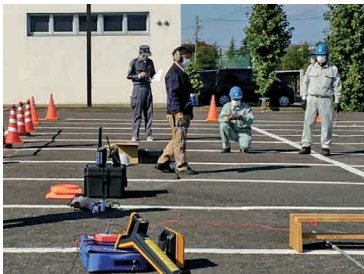
漏水箇所調査訓練
