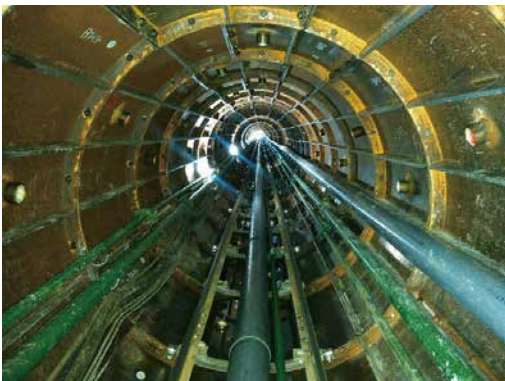
写真3 一次掘削中の坑内
