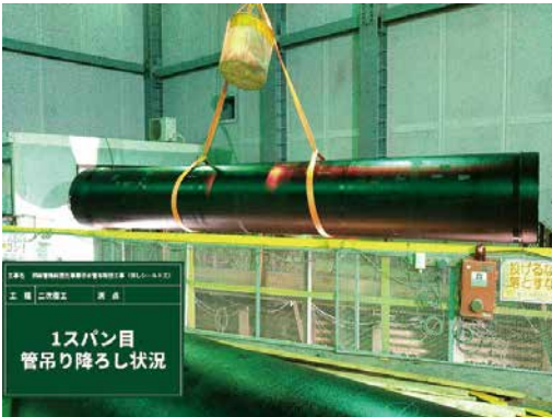
写真5 坑内へのダクトイル鉄管の吊り降ろし
