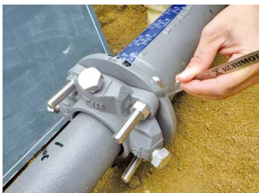
写真5 G-Link の隙間ゲージによる確認
