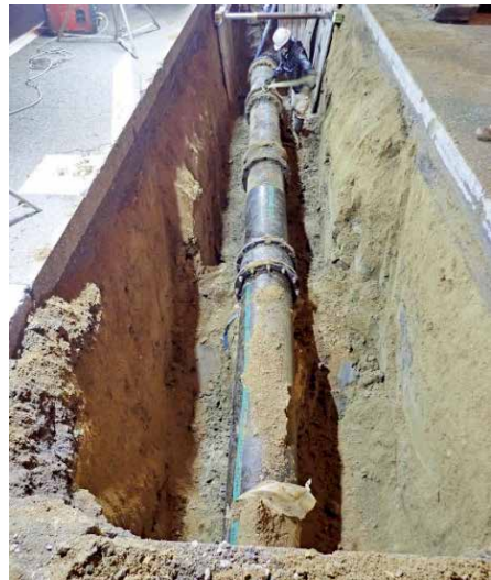
写真3 調査管の状況
