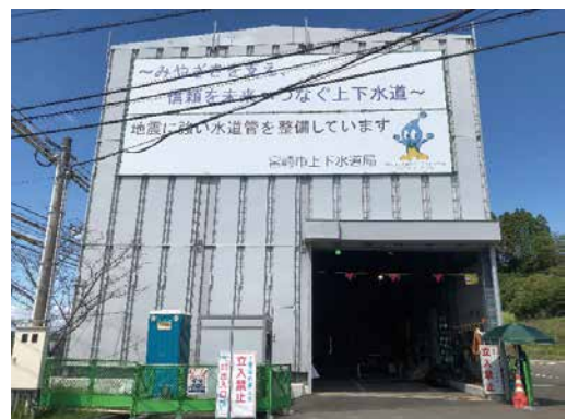
写真10 発進立坑の防音ハウス
