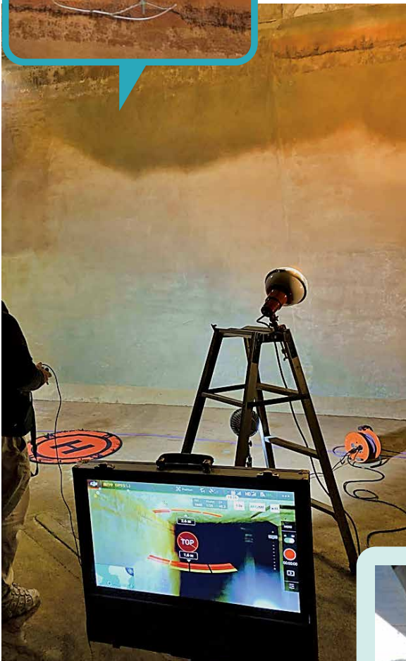
配水池内部点検の様子
