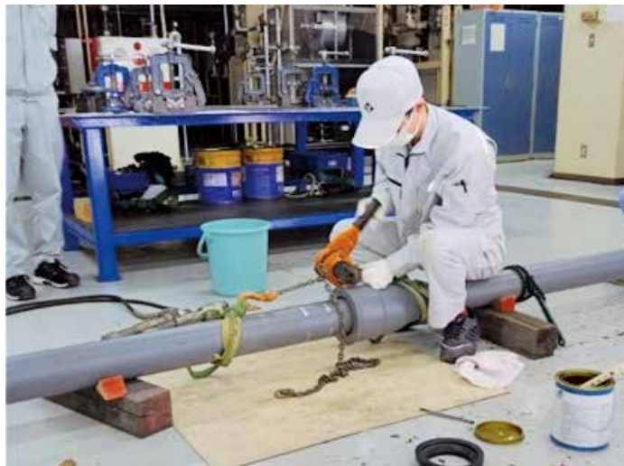
GX形ダクタイル鉄管接合実習の様子
