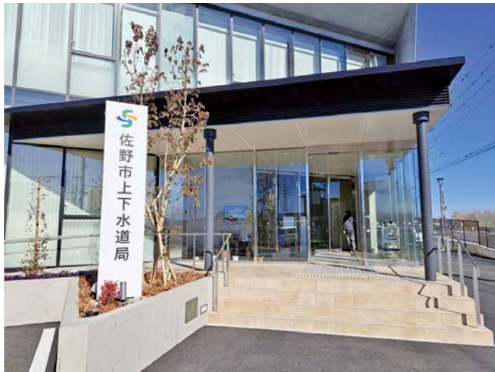
佐野市新上下水道庁舎 正面玄関
