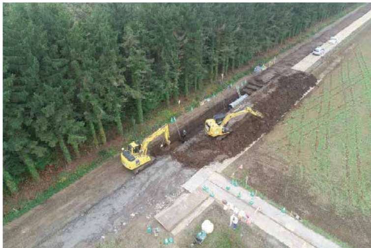
写真3 管体工・施工状況
