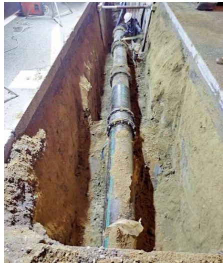
写真3 調査管の状況
