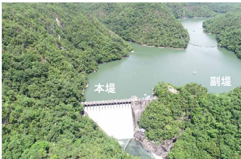
写真5 千苜ダム 全景
