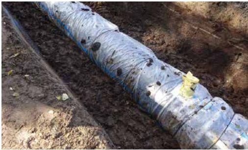
写真2 ポリエチレンスリーブ被覆状況
