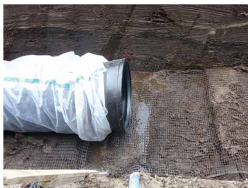
写真1 不同沈下抑制シート敷設状況
