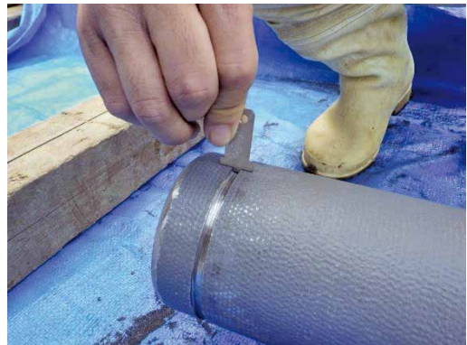
写真2 チェックゲージを用いた溝深さの確認
