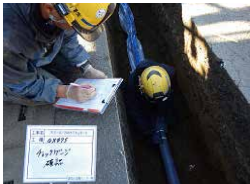
写真3 ゴム輪の位置確認(GX形管)
