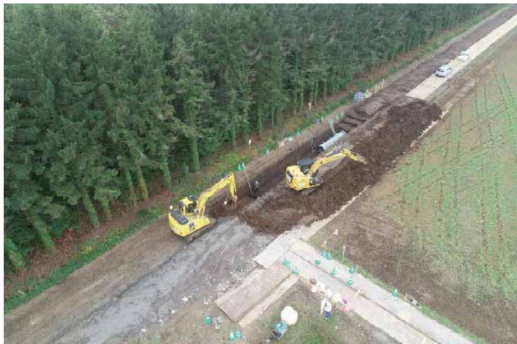
写真3 管体工・施工状況
