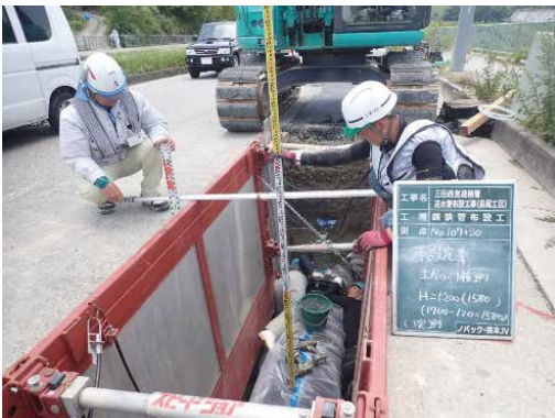
写真 2 長尾工区開削工その 2
