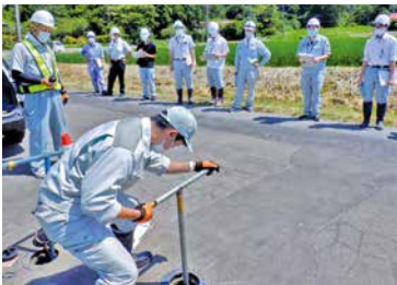
通水洗管作業研修
