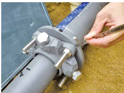
写真5 G-Link の隙間ゲージによる確認
