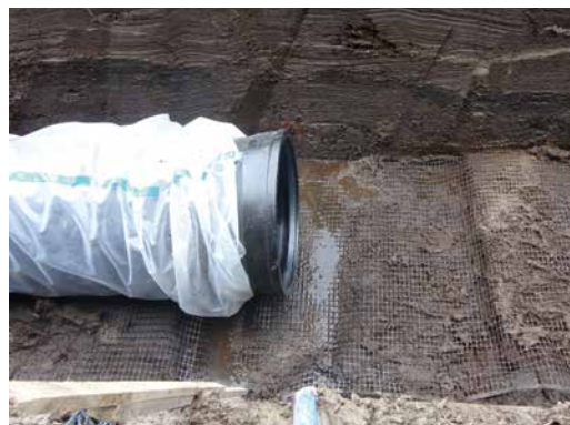
写真1 不同沈下抑制シート敷設状況
