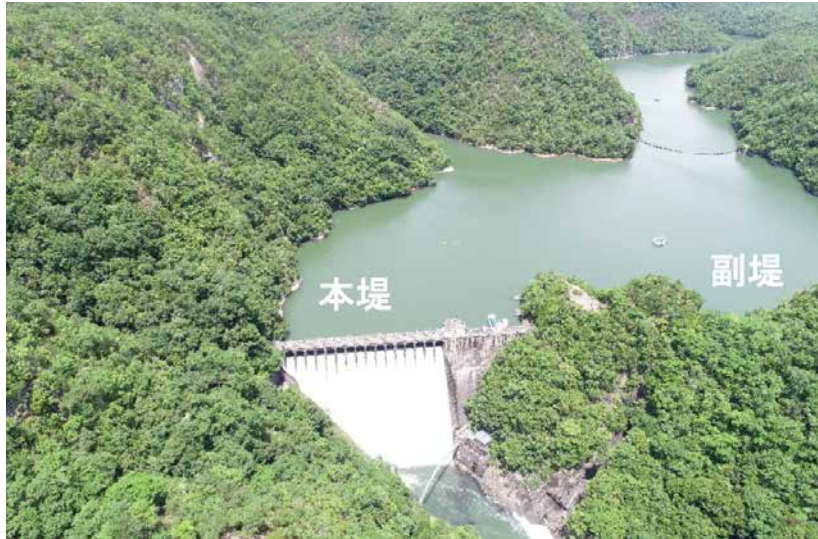
写真5 千苅ダム 全景
