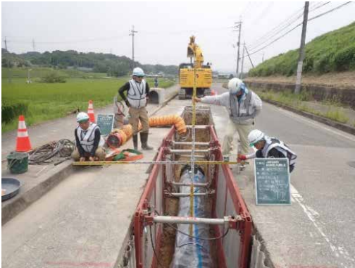
写真 1 長尾工区開削工その 1
