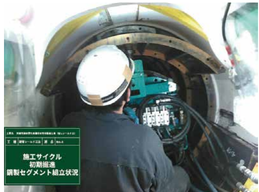
写真2 鋼製セグメントの組立
