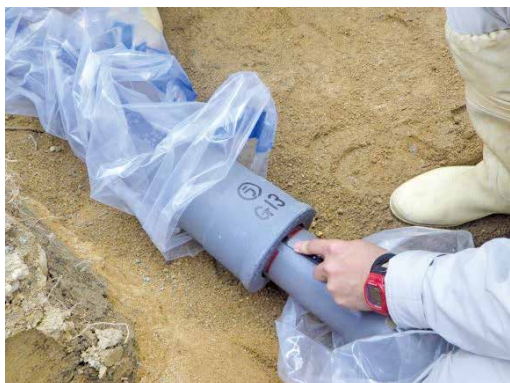
写真4 チェックゲージによるゴム輪の位置確認
