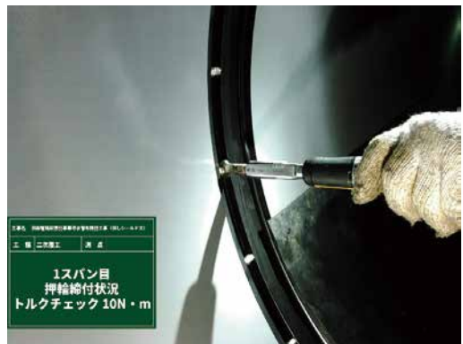
写真8 管の接合(押輪の締付け)
