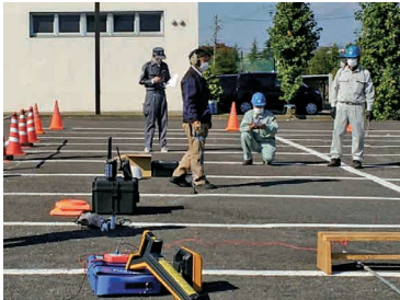
漏水箇所調査訓練
