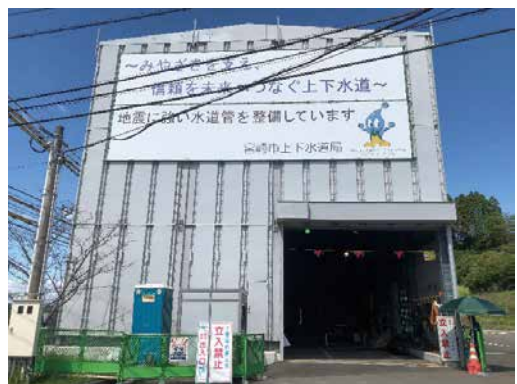
写真10 発進立坑の防音ハウス
