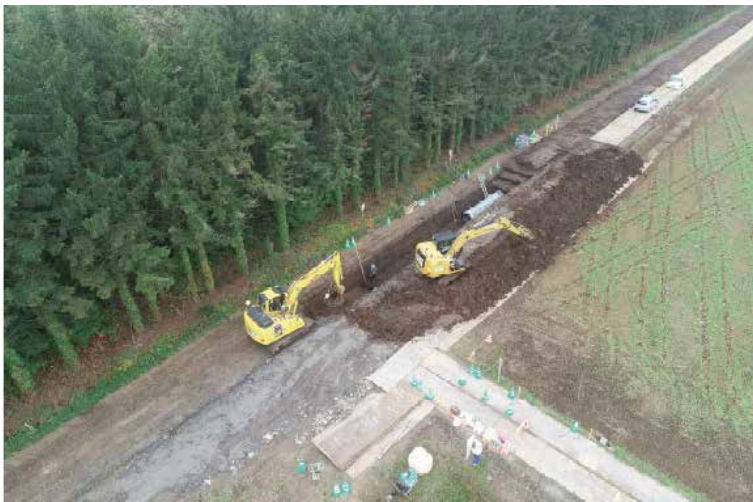
写真3 管体工・施工状況
