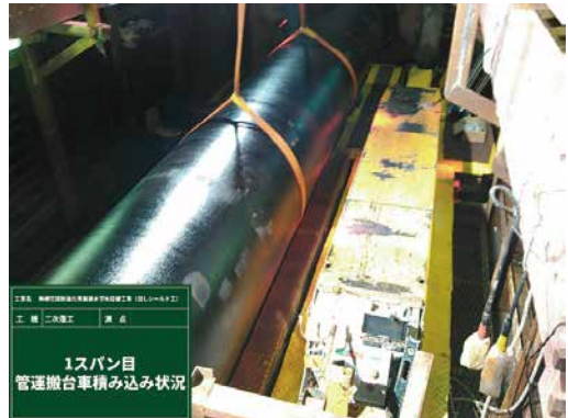
写真6 管運搬台車への積載
