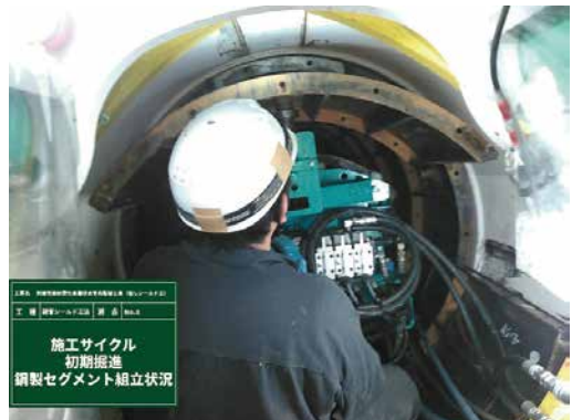
写真2 鋼製セグメントの組立
