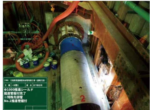
写真 4 道場工区シールド工その 2
