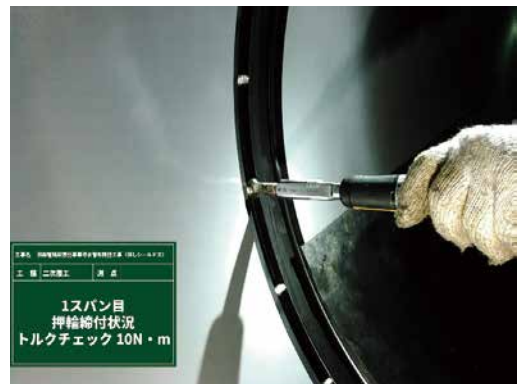
写真8 管の接合(押輪の締付け)
