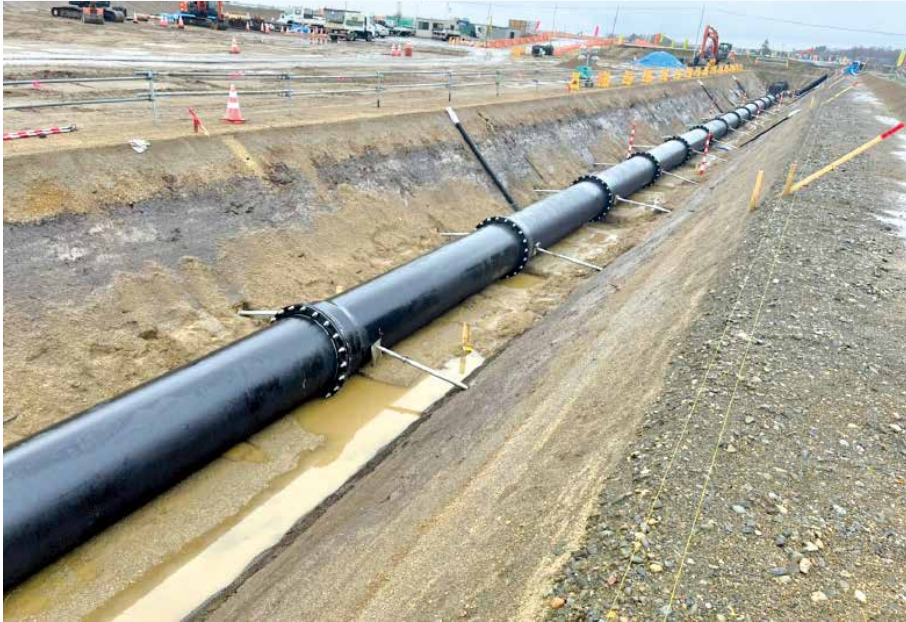
北海道開発局室蘭開発建設部胆振農業事務所 NS形 呼び径 1000
