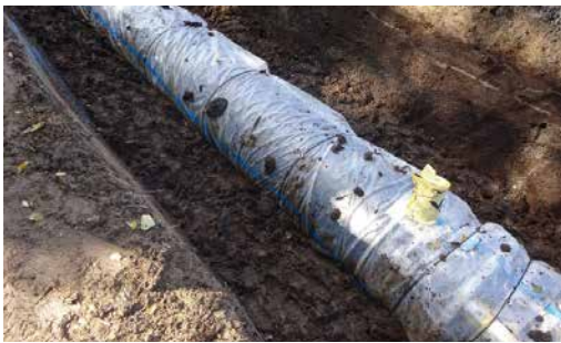
写真2 ポリエチレンスリーブ被覆状況
