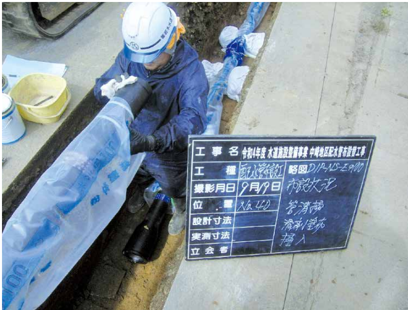
弘前市上下水道局（青森県） NS形 E種 呼び径 100
