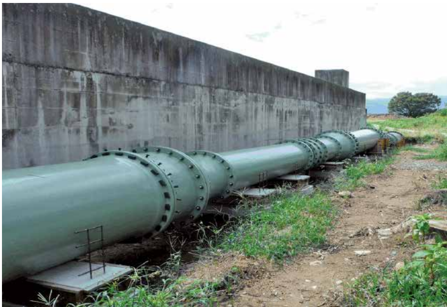
山梨県流域下水道事務所 K形 呼び径 1000
