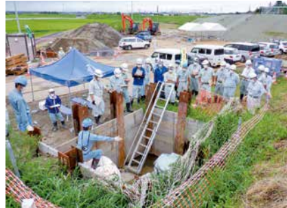
不断水施工現場研修
