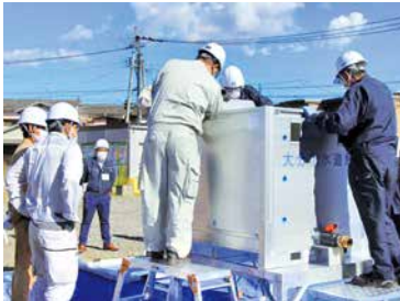
仮設水槽(コンテナ)の組み立て訓練
