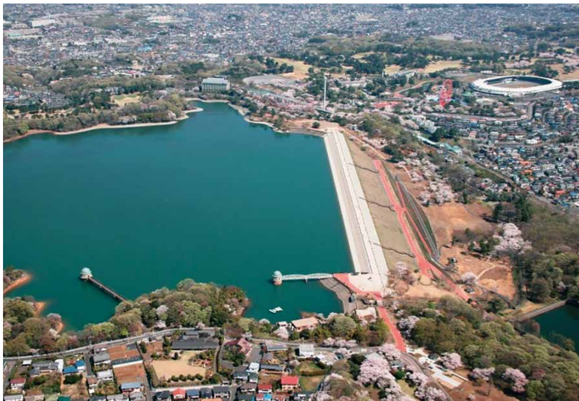
【写真：堤体強化工事を実施した村山下貯水池】
