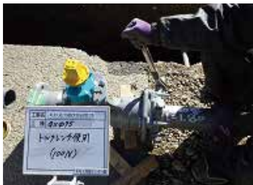
写真4 嵐山仕様の仕切弁とトルク管理
