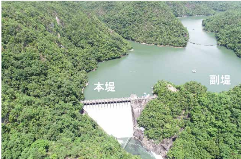
写真5 千苜ダム 全景
