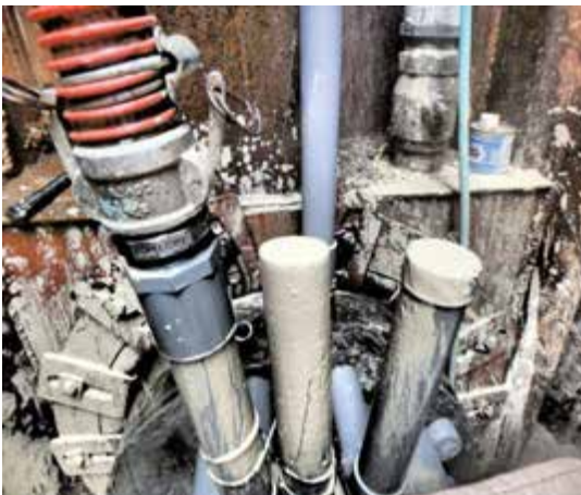
写真9 中詰め注入状況②
