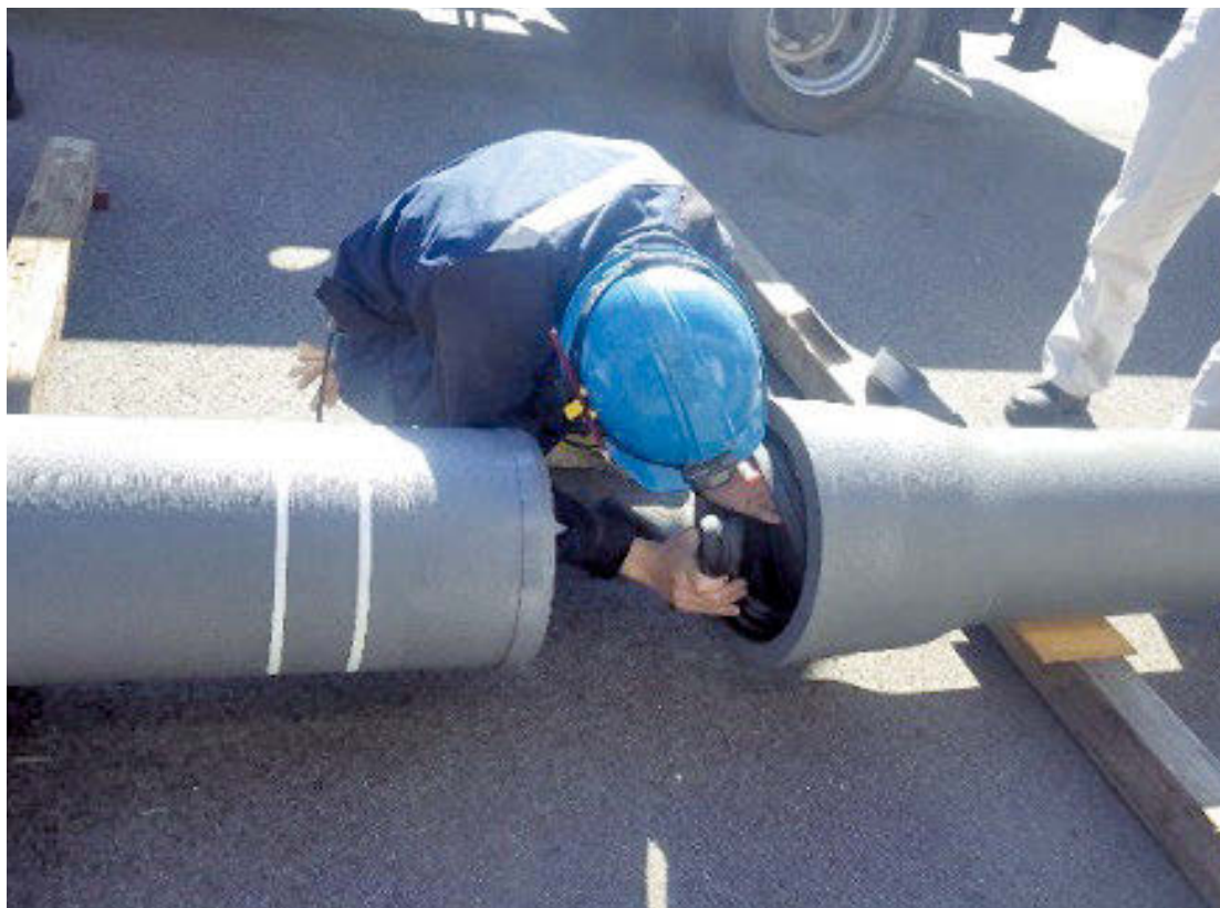
写真3 着手前の技術講習の状況
