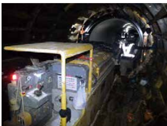
写真2 管挿入状況
