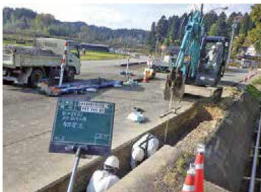
写真3 配水管布設状況 (市道)
