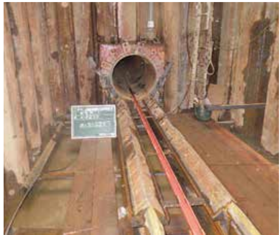
写真4 挿入設備設置状況
