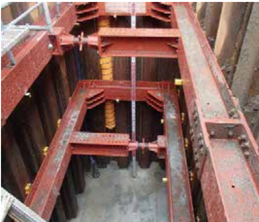
写真1 発進立坑の状況
