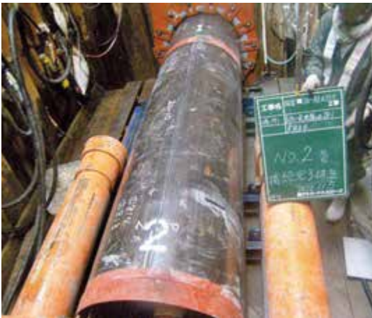
写真3 共同管推進状況
