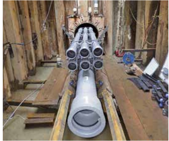
写真6 共同管内への推進状況
