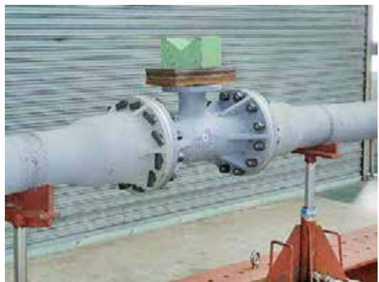
写真2 空気弁ウエイト設置状況
