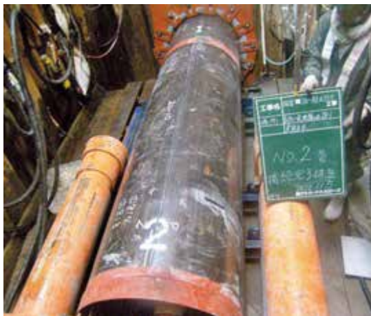
写真3 共同管推進状況
