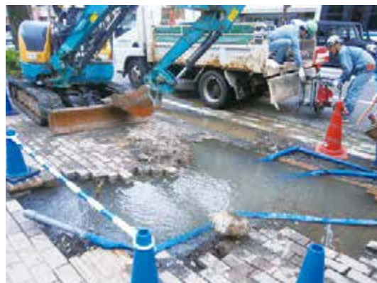
派遣 (H28 熊本地震 応急復旧)
