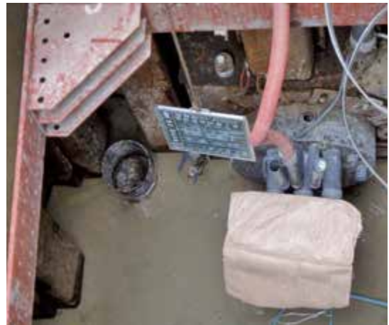
写真8 中詰め注入状況①
