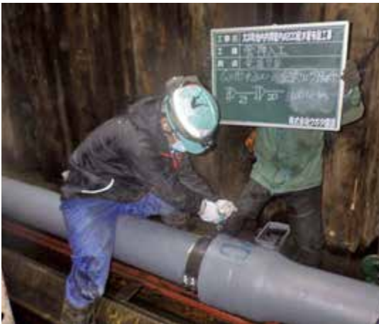
写真7 推力伝達リング取り付け状況
