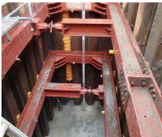
写真1 発進立坑の状況
