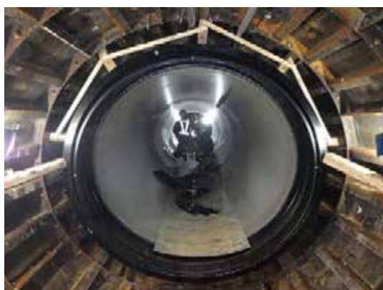
写真3 管据付完了
