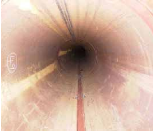
写真5 ガイドレール設置状況
