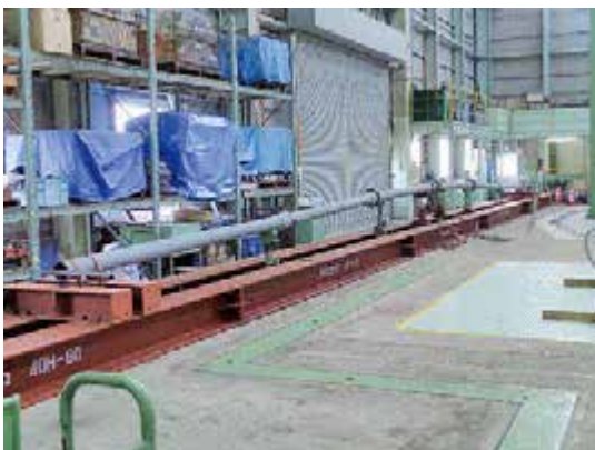
写真1 水管橋仮組み検査状況全景
