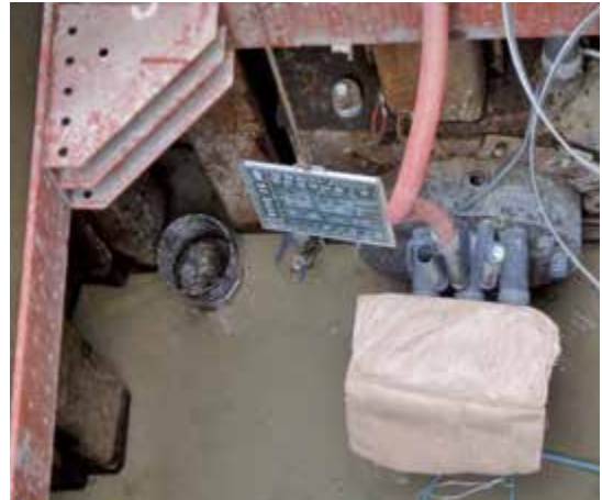
写真8 中詰め注入状況①
