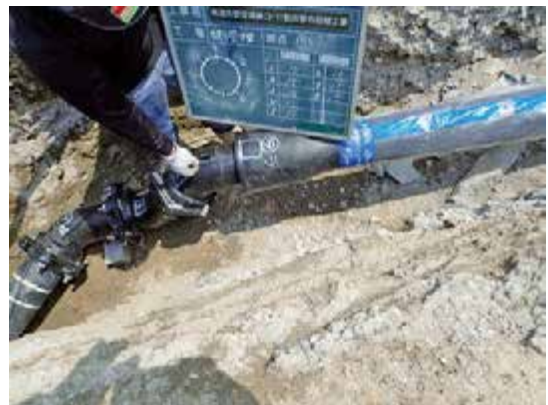
写真2 工事の様子②
