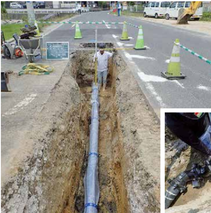
写真1 工事の様子①
