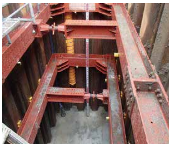
写真1 発進立坑の状況
