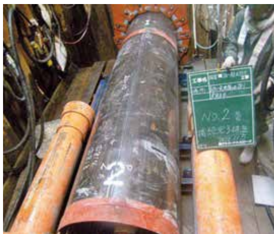
写真3 共同管推進状況
