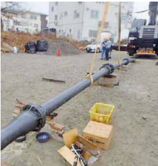
写真3 水管橋陸組状況
