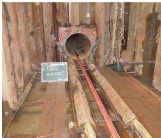
写真4 挿入設備設置状況
