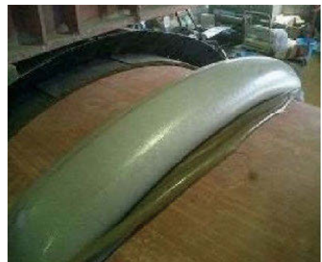
写真6 袋付きセグメントの設置例
