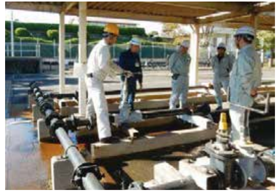
工事業者の研修
