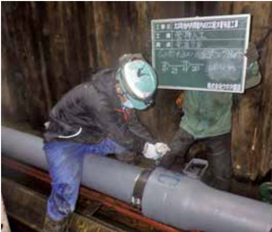
写真7 推力伝達リング取り付け状況
