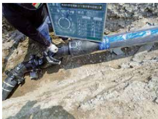
写真2 工事の様子②
