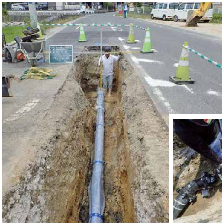
写真1 工事の様子①
