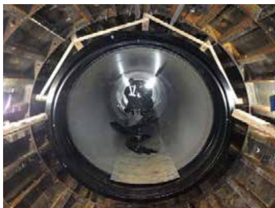
写真 3 管据付完了
