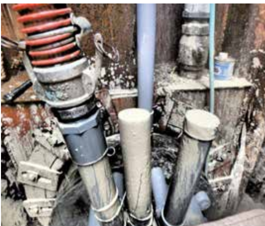
写真9 中詰め注入状況②
