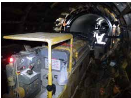
写真 2 管挿入状況
