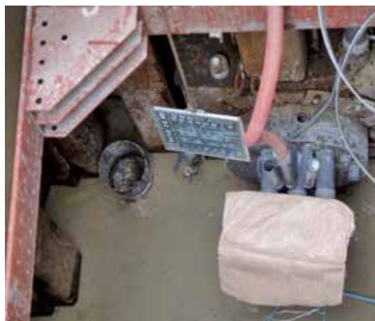
写真8 中詰め注入状況①
