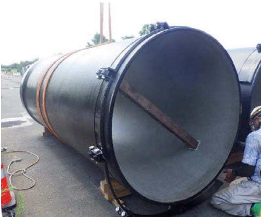
写真4 キャスターバンド取付状況
