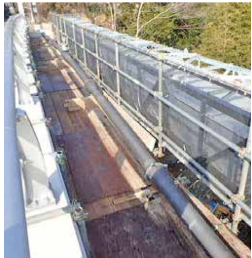
写真5 水管橋据付完了
