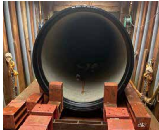
写真5 管挿入状況
