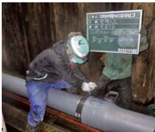
写真7 推力伝達リング取り付け状況
