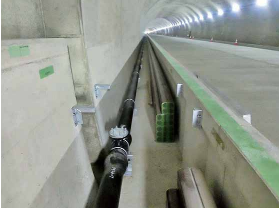
国土交通省中部地方整備局（静岡県）T形 呼び径 150
