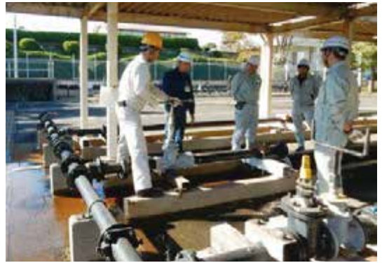
工事業者の研修
