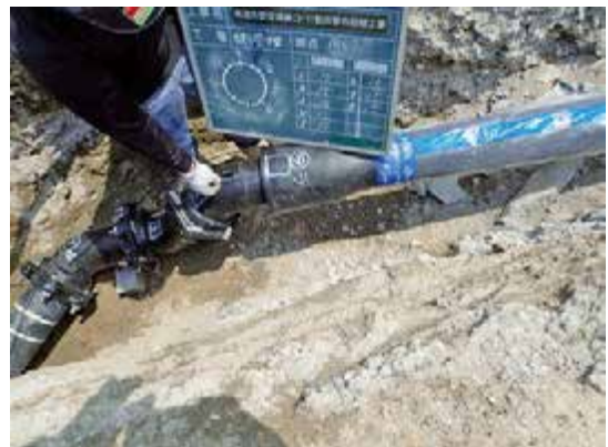
写真2 工事の様子②
