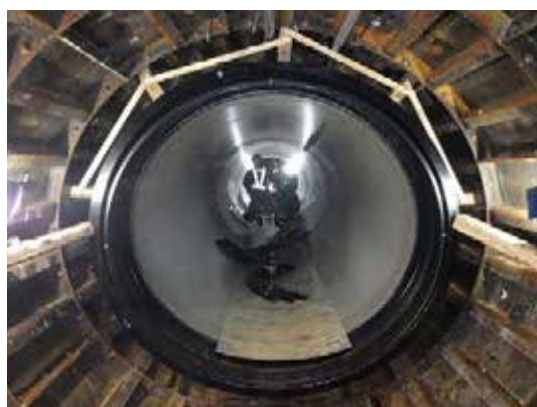
写真3 管据付完了
