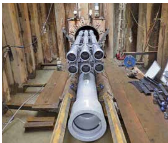
写真6 共同管内への推進状況
