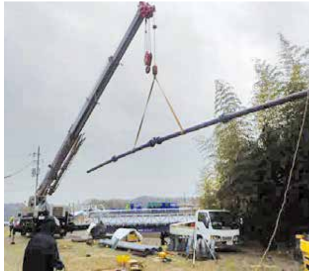
写真4 FGX形一括吊込み状況
