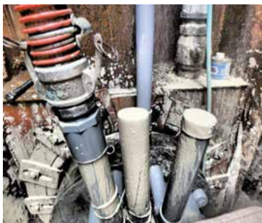
写真9 中詰め注入状況②
