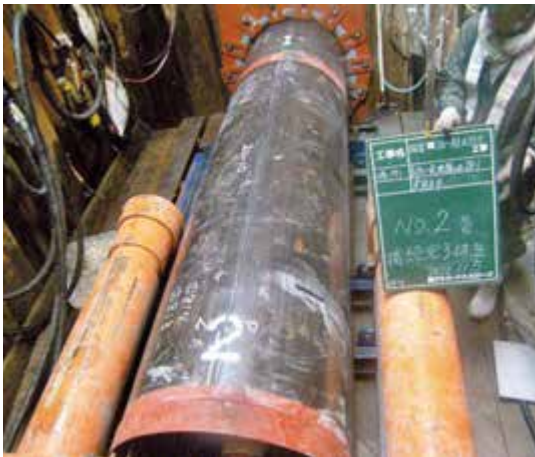
写真3 共同管推進状況
