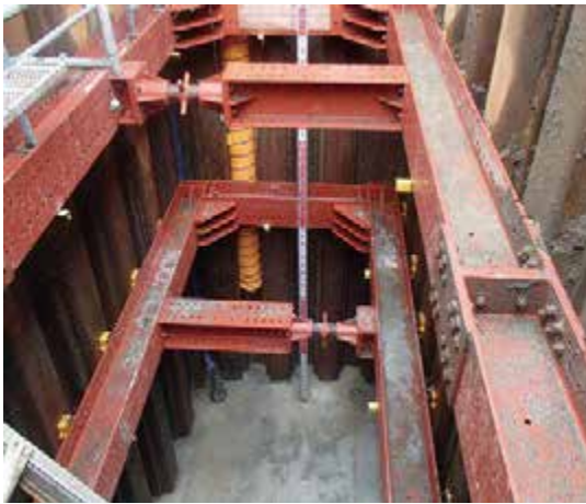
写真1 発進立坑の状況
