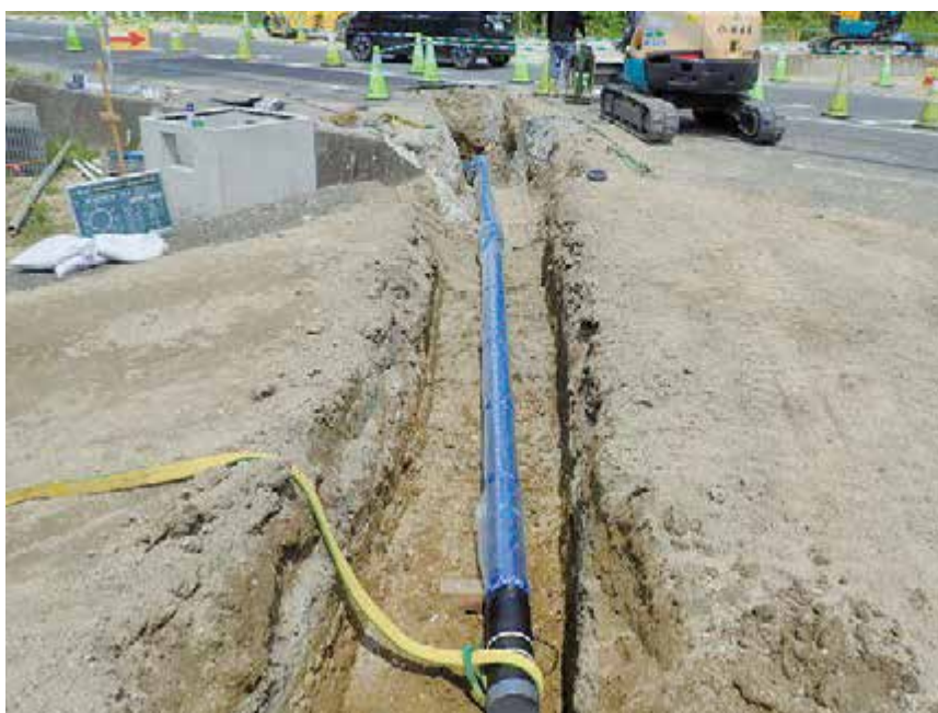
写真 3 工事の様子③
