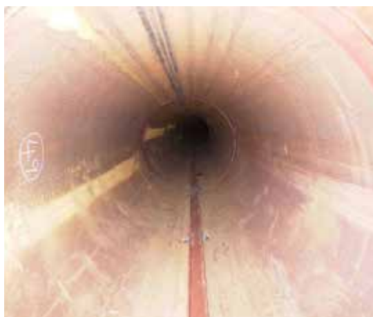
写真5 ガイドレール設置状況
