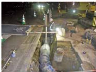
GX形ダクタイル鉄管(φ300mm)布設状況
