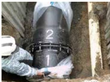
NS形ダクタイル鉄管(φ600mm)布設状況
