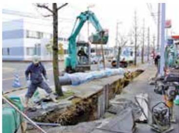
GX形ダクタイル鉄管(φ300mm)布設状況
