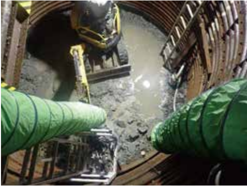
写真10 No.2 中間立坑掘削状況
