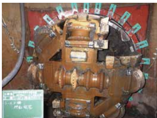
写真6 シールドマシン到達(令和2年5月)
