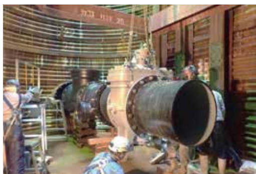
写真16 No.3 中間立坑部配管状況
