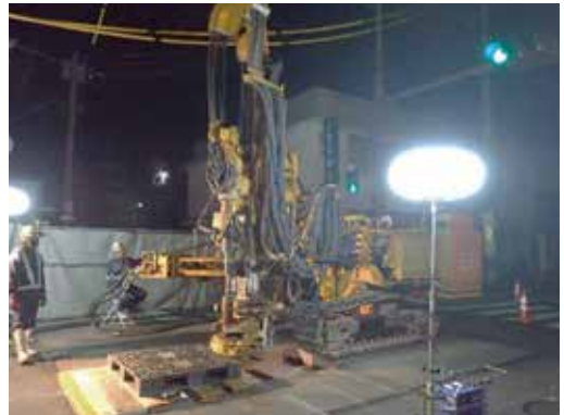
写真13 No.2 中間立坑補助削孔状況
