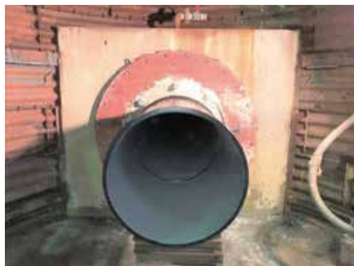
写真9 シールド内配管完了(令和3年1月)
