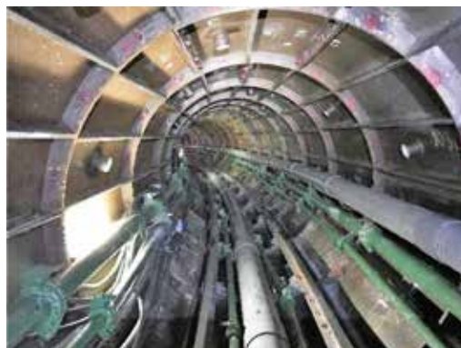
写真5 シールド掘進開始(平成30年12月)
