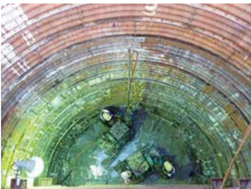
写真14 No.3 中間立坑補助削孔状況
