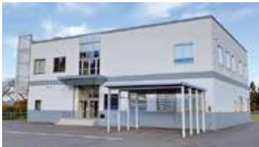
水質管理センター外観
