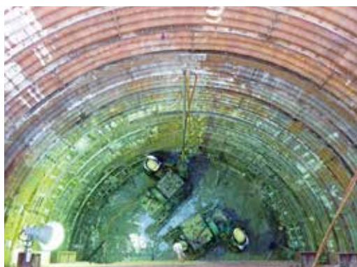
写真14 No.3 中間立坑補助削孔状況
