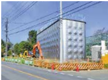
老朽化した浄水場を配水場化
