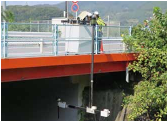
■ 橋梁添架管点検カメラ（横浜市）
