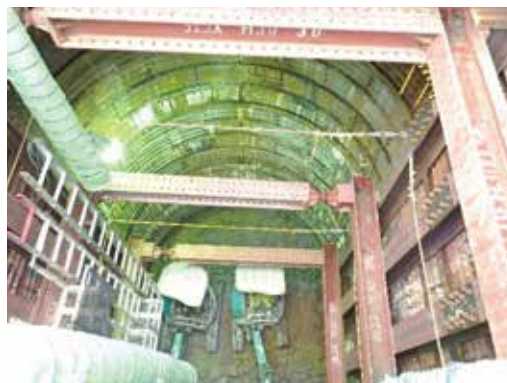
写真11 No.3 中間立坑掘削状況
