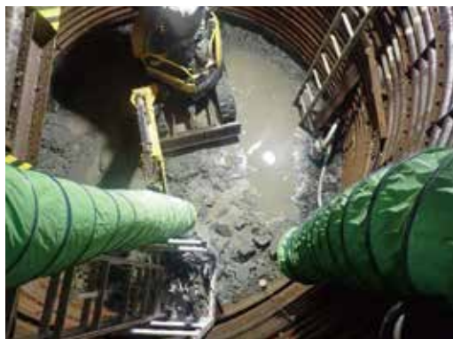
写真10 No.2 中間立坑掘削状況
