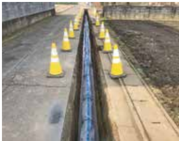
GX 形ダクタイル鉄管も使用
