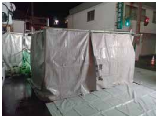
写真12 No.2 中間立坑防音対策状況
