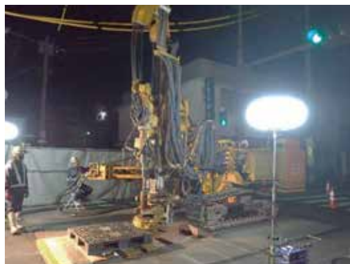
写真13 No.2 中間立坑補助削孔状況
