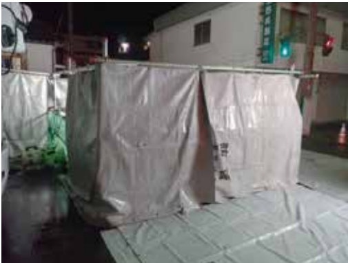
写真12 No.2 中間立坑防音対策状況
