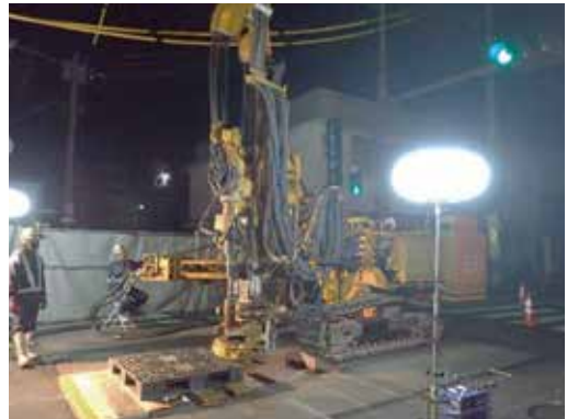
写真13 No.2 中間立坑補助削孔状況
