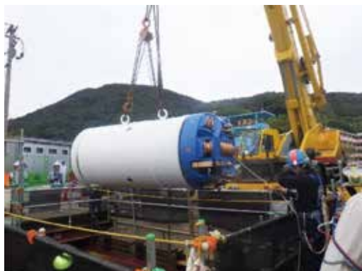
写真4 シールドマシン搬入(平成30年10月)
