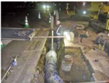
GX形ダクタイル鉄管(φ300mm)布設状況
