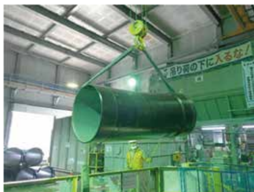
写真7 シールド内配管開始(令和2年7月)
