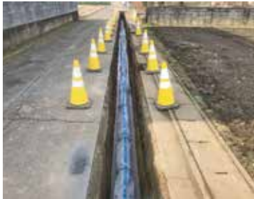
GX 形ダクタイル鉄管も使用
