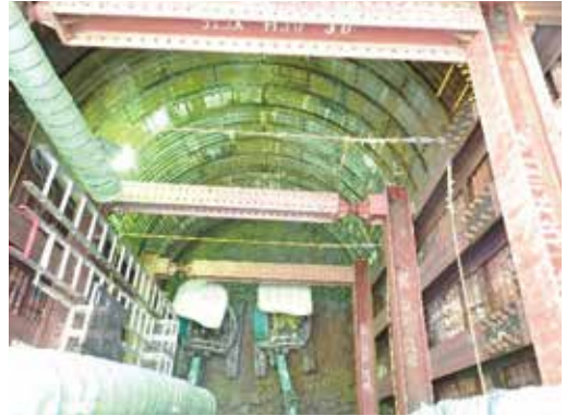
写真11 No.3 中間立坑掘削状況
