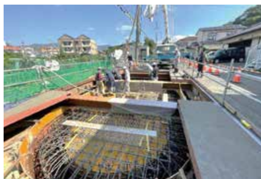
写真17 No.3 弁室築造状況
