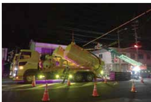
写真18 No.2 中間立坑埋戻状況
