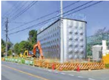
老朽化した浄水場を配水場化
