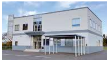
水質管理センター外観
