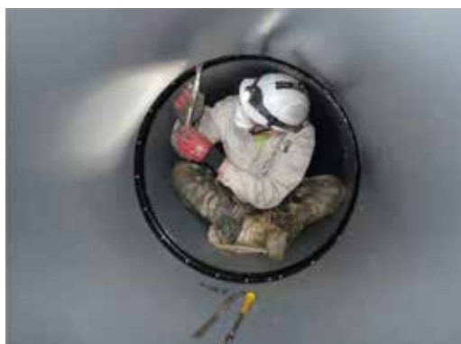
写真8 PN形継手の接合状況
