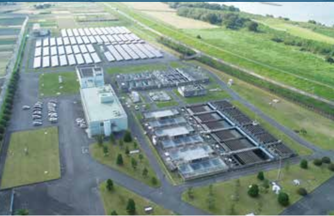
高効率天日乾燥施設を有する第十浄水場
