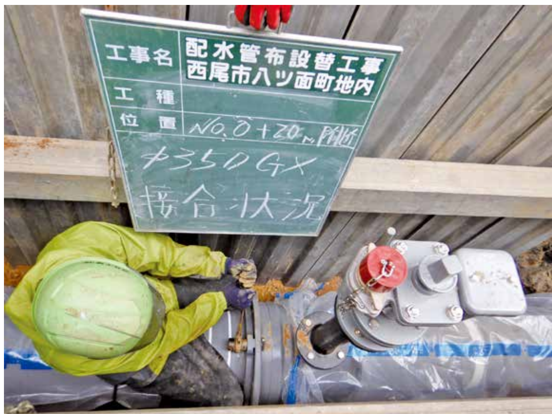
西尾市上下水道部(愛知県) GX形 呼び径 350
