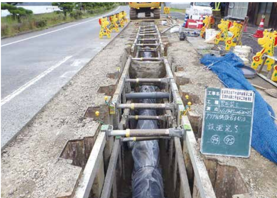
京都府流域下水道事務所(宮津湾浄化センター) NS形 呼び径 450
