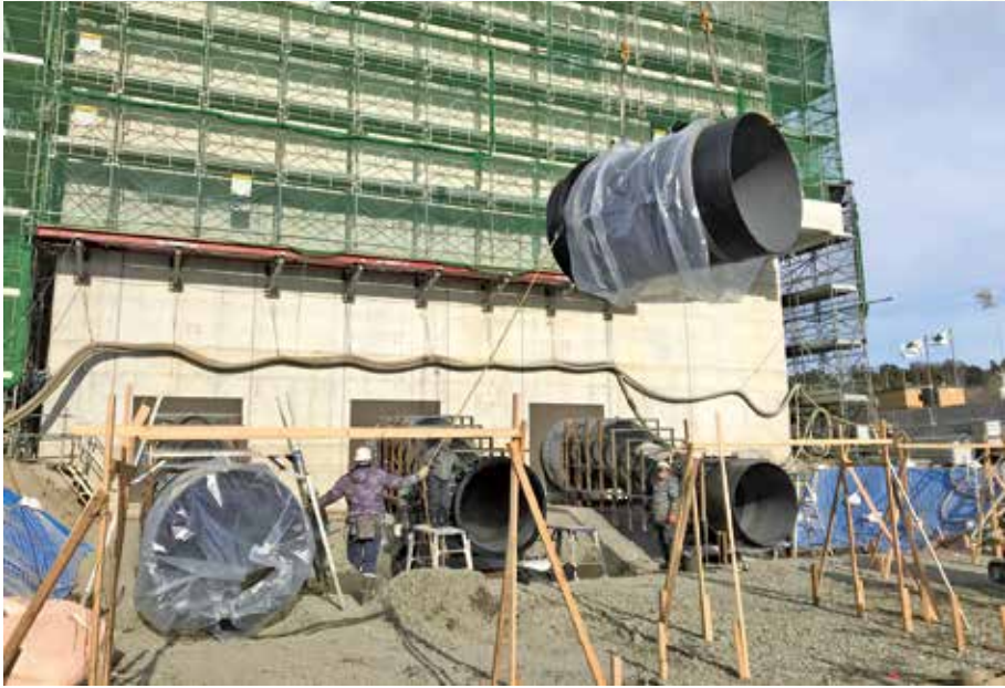
日本下水道事業団 東北総合事務所(石巻分室) K形 呼び径 1500
