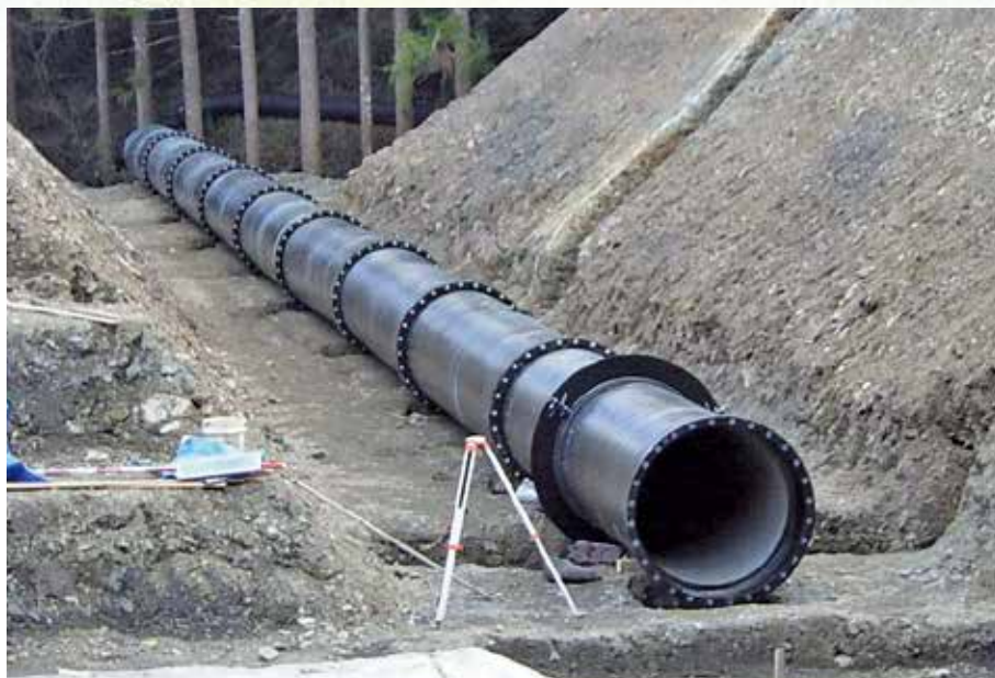
高知県中央東農業振興センター S形 呼び径 1200 (柔構造ため池底樋)
