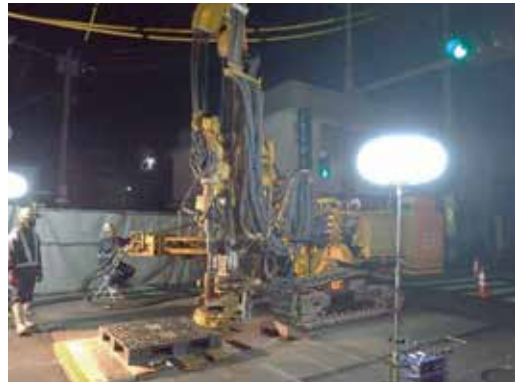
写真13 No.2 中間立坑補助削孔状況
