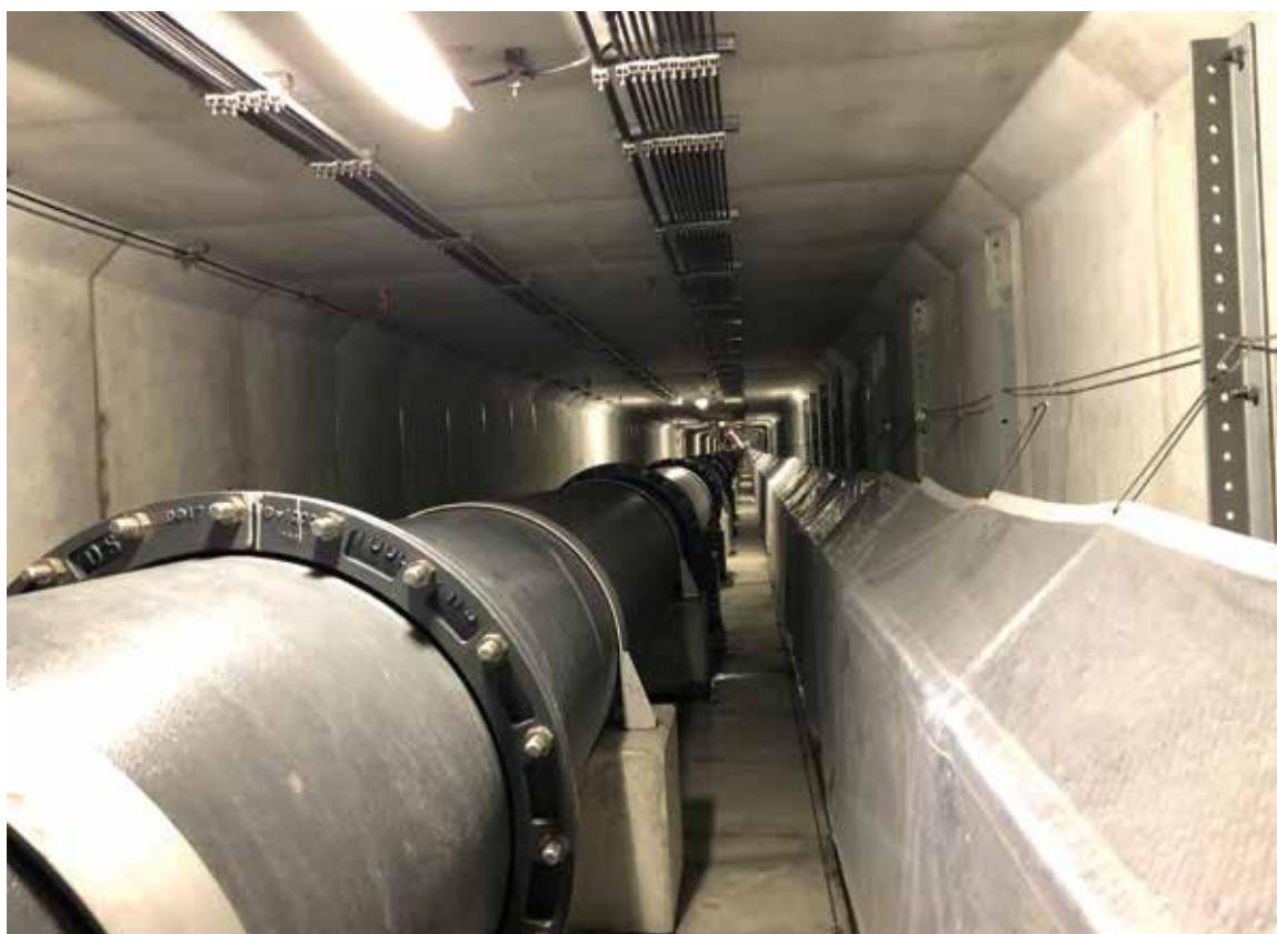
■ 広島南幹線共同溝に整備した 1,000 mm NS形ダクタイル鉄管（外面特殊塗装管）
