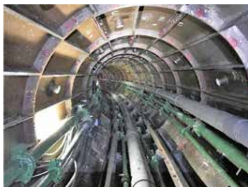
写真5 シールド掘進開始(平成30年12月)
