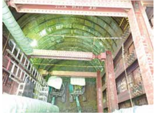
写真11 No.3 中間立坑掘削状況
