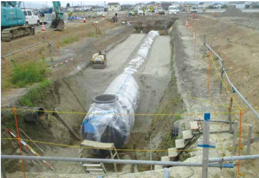
板野町水道課(徳島県) LUF形 呼び径 1500 (耐震貯水槽)
