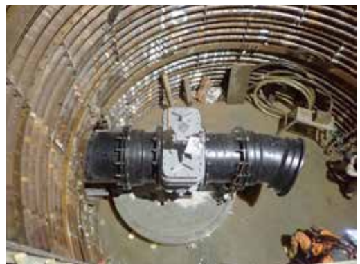
写真15 No.2 中間立坑部配管状況
