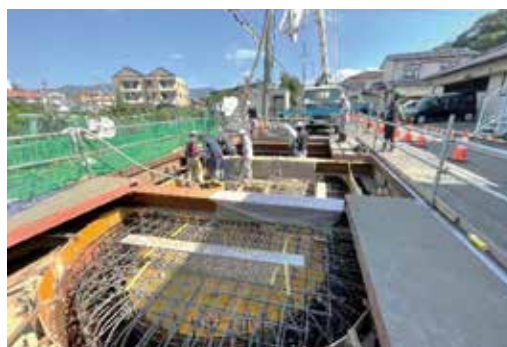
写真17 No.3 弁室築造状況
