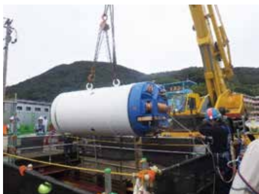
写真4 シールドマシン搬入(平成30年10月)
