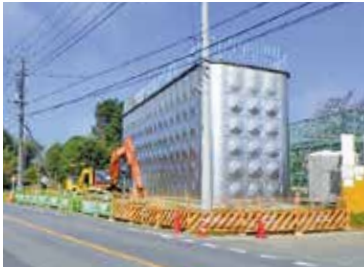
老朽化した浄水場を配水場化
