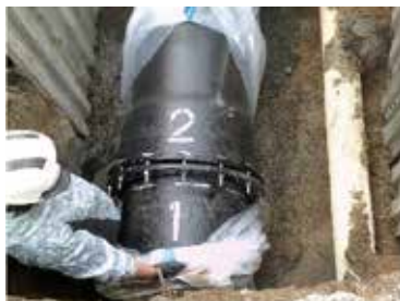
NS形ダクタイル鉄管(φ600mm)布設状況
