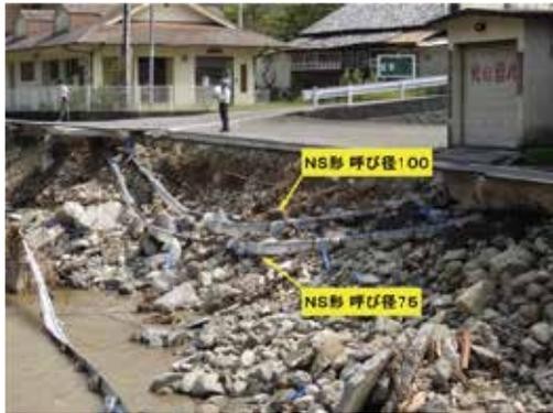
図4 豪雨による道路崩壊に耐えた耐震管路
