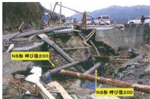
図3 津波による道路崩壊に耐えた耐震管路
