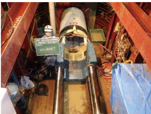
写真 1 一次覆工推進状況
