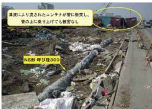
図5 東日本大震災の津波に耐えた耐震管路
