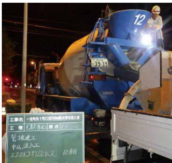
写真 15 中込充填状況 1(ミキサー車側)
