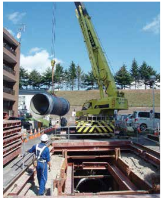
写真2 管吊おろし状況
