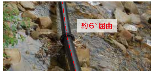
写真3 許容曲げ角度を超過した継手
