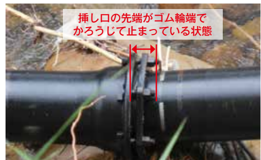
写真4 許容胴付間隔を超過した継手
