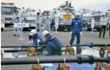
応急復旧訓練の様子
