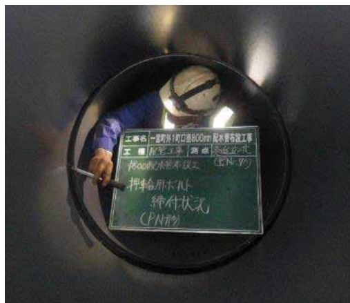
写真 8 PN 形接合状況 2(ボルト締付け)
