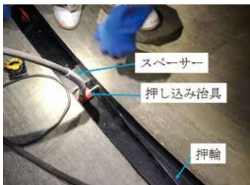
写真5 配管接合状況
