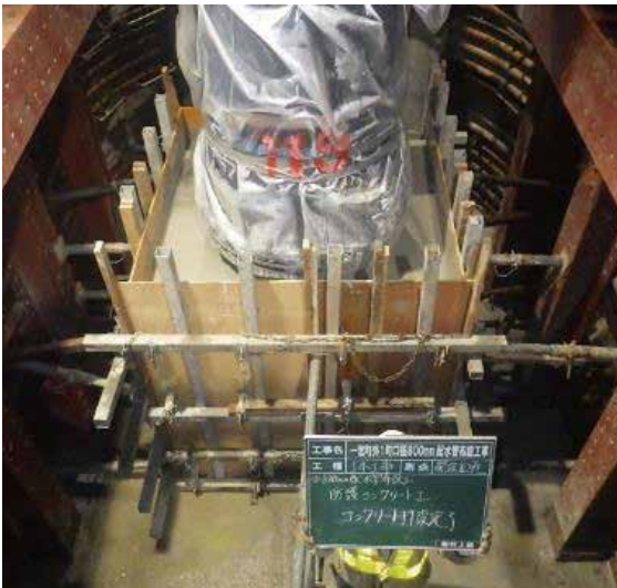
写真 12 防護コンクリート型枠組立状況 (発進立坑側)
