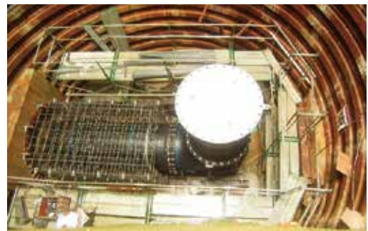
写真4 立坑内配管状況
