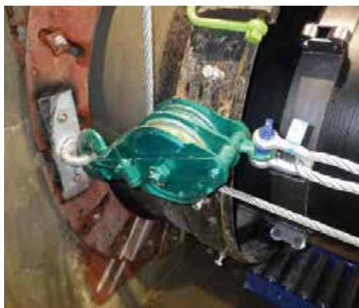
写真 6 坑口側滑車状況
