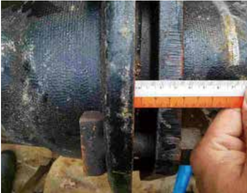
写真5 継手計測状況
