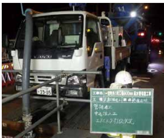
写真 16 中込充填状況 2(3tトラック側)
