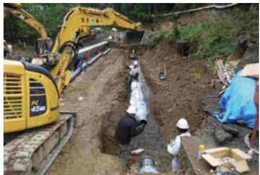
写真8 本設管施工状況(吊り下ろし)
