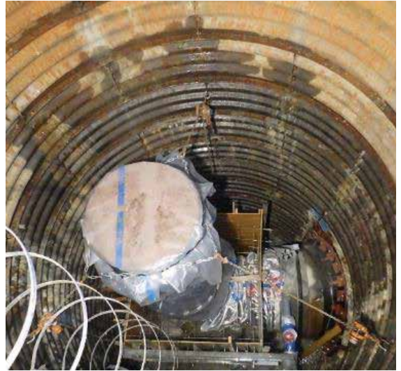
写真 13 防護コンクリート型枠組立状況 (到達立坑側)
