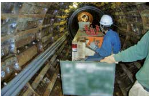
写真3 管運搬状況
