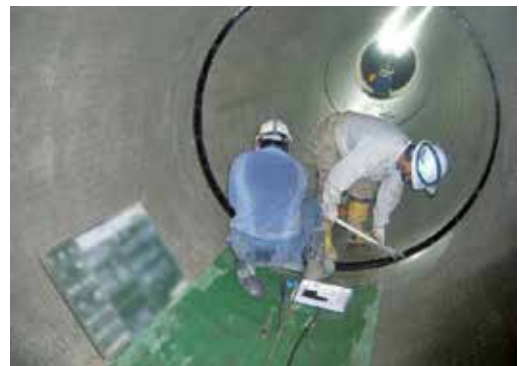
写真9 管接合状況
