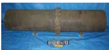
図20 53年間使用された管の外観状況
