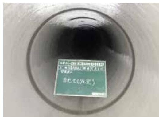
写真2 一次覆工目地詰め後
