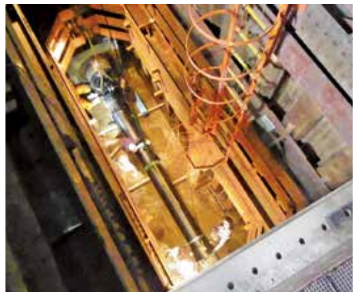
写真8 立坑内への直管搬入状況
