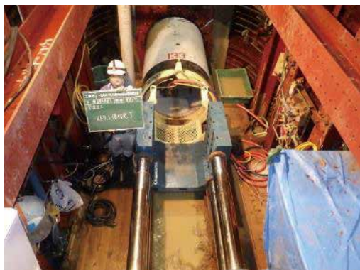
写真1 一次覆工推進状況
