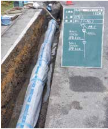
工事風景(ダクタイル鉄管 GX 形)
