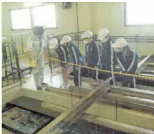
沈澱池にライトを当ててフロックを見学
