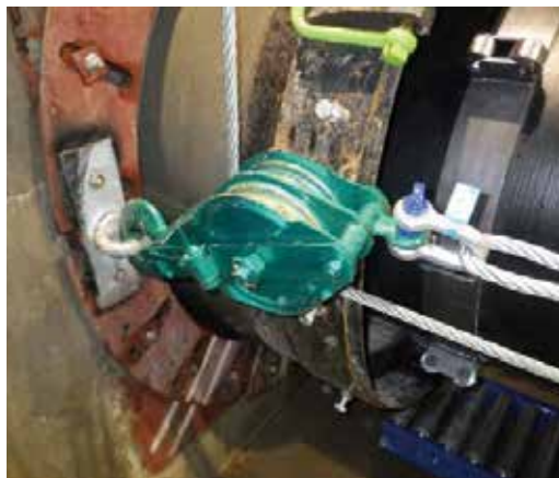
写真 6 坑口側滑車状況
