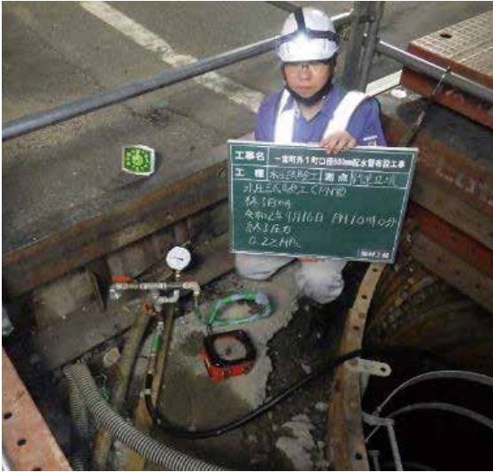
写真 11 水圧試験終了時の状況
