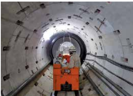
写真8 管運搬状況
