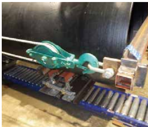
写真 5 PN 形受口側滑車状況
