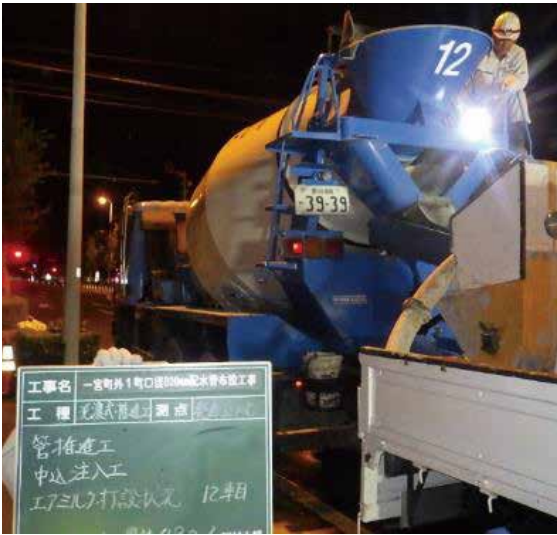
写真 15 中込充填状況 1(ミキサー車側)
