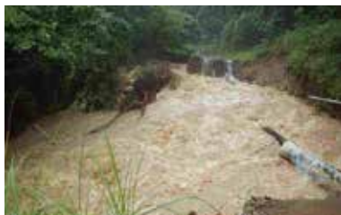
写真1 被害状況(道路崩壊直後)
