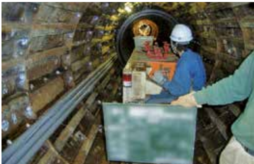
写真3 管運搬状況
