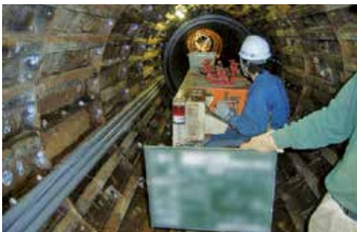
写真3 管運搬状況
