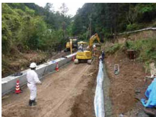
写真10 本設管施工状況(据付後)
