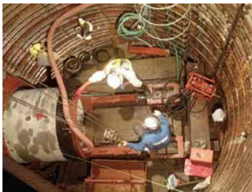
写真3 さや管掘進状況
