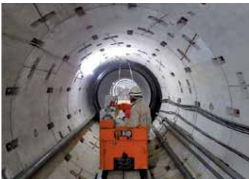
写真8 管運搬状況
