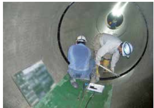
写真9 管接合状況
