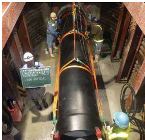
写真 7 PN 形接合状況 1 (管挿入)
