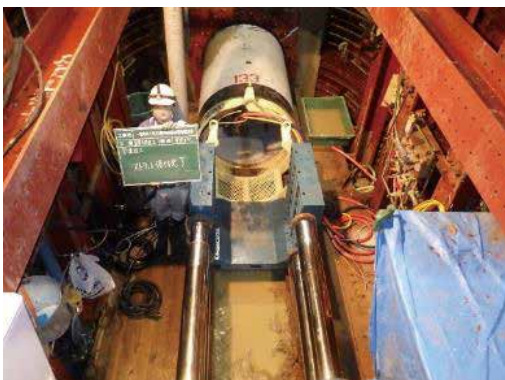
写真 1 一次覆工推進状況
