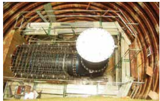
写真4 立坑内配管状況
