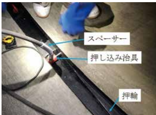
写真5 配管接合状況
