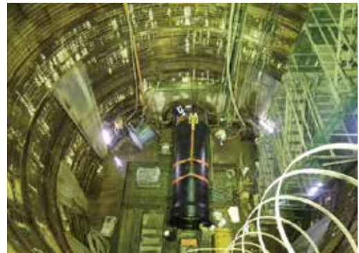
写真7 管吊おろし状況 (立坑内)
