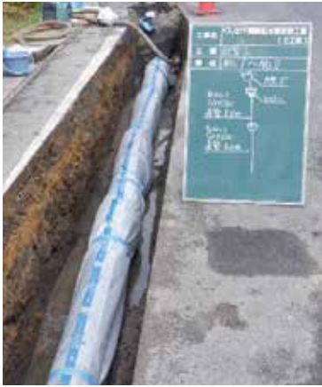
工事風景(ダクタイル鉄管 GX 形)
