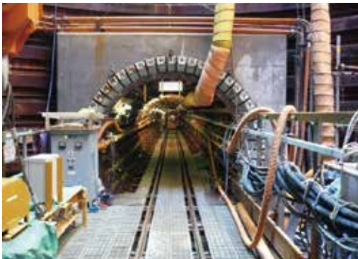
写真6 シールド工法 (豊平川横断工区)
