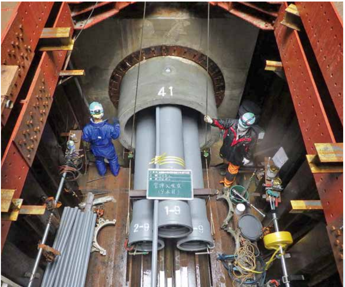
交野市水道局 (大阪府) GX形 呼び径 400 × 3 条
