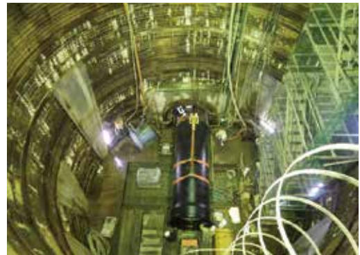
写真7 管吊おろし状況 (立坑内)
