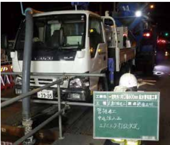
写真 16 中込充填状況 2(3tトラック側)
