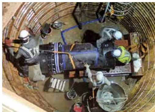
写真4 本管挿入状況
