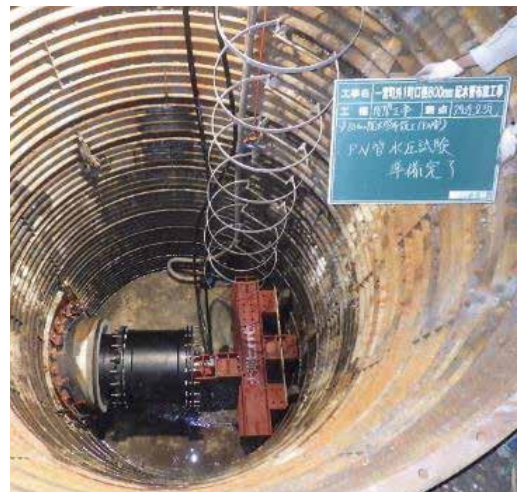
写真 10 水圧試験時の栓止め状況(到達立坑側)
