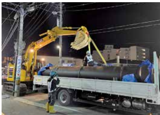
写真2 管吊り上げ状況
