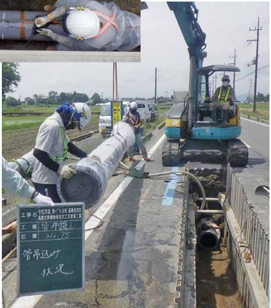
滋賀県北部流域下水道事務所 GX形 呼び径 300
