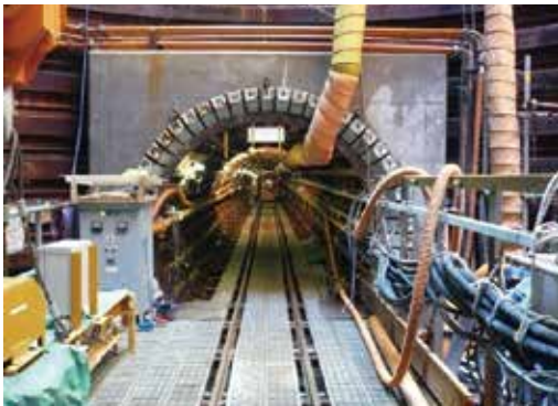
写真6 シールド工法 (豊平川横断工区)
