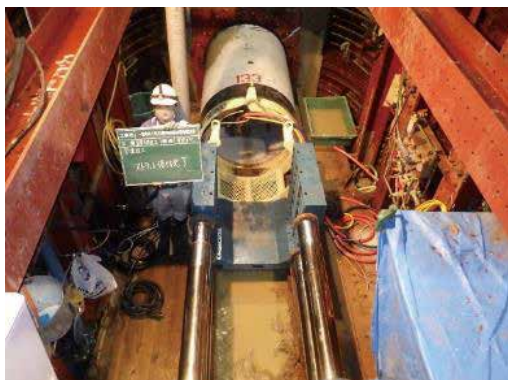
写真 1 一次覆工推進状況
