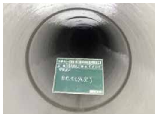
写真 2 一次覆工目地詰め後
