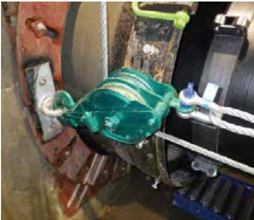
写真 6 坑口側滑車状況
