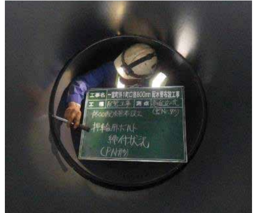
写真 8 PN 形接合状況 2(ボルト締付け)
