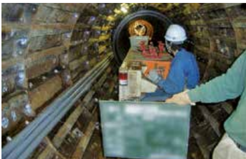
写真3 管運搬状況
