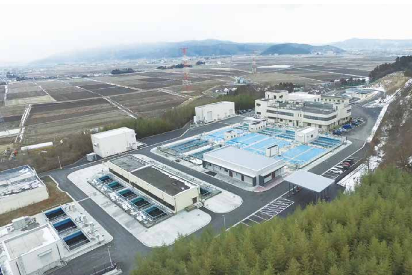
須江山浄水場全景（提供：石巻地方広域水道企業団）
