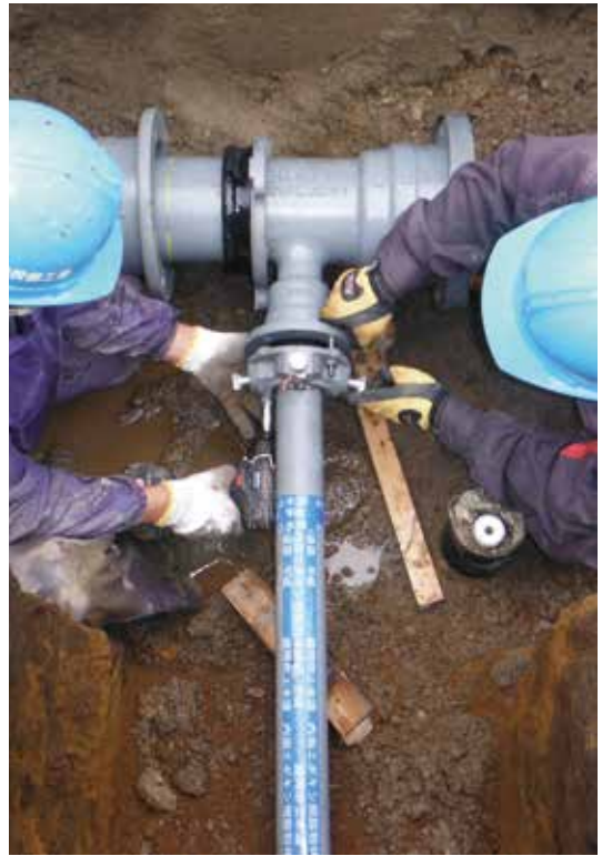
S50形ダクタイル鉄管布設（提供：盛岡市）
