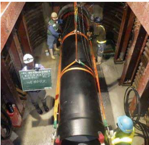
写真 7 PN 形接合状況 1(管挿入)
