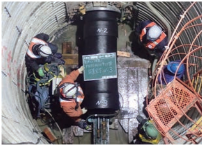
基幹管路整備（推進部 DIP-PN φ600mm）
