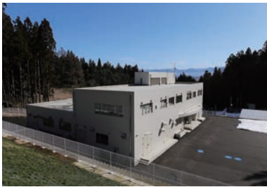
宇津台浄水場全景山側から望む
