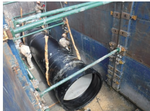
写真2 管接合状況 (US形 呼び径 1500)
